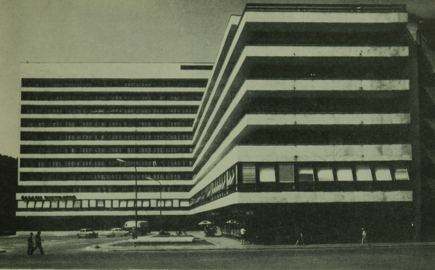
1. ábra. A lakóépület homlokzata
