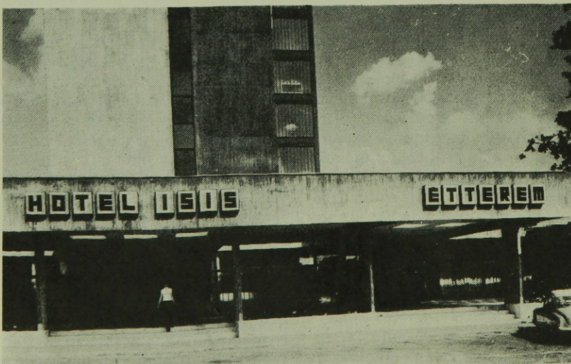
3. ábra. Főbejárat felőli részlet
