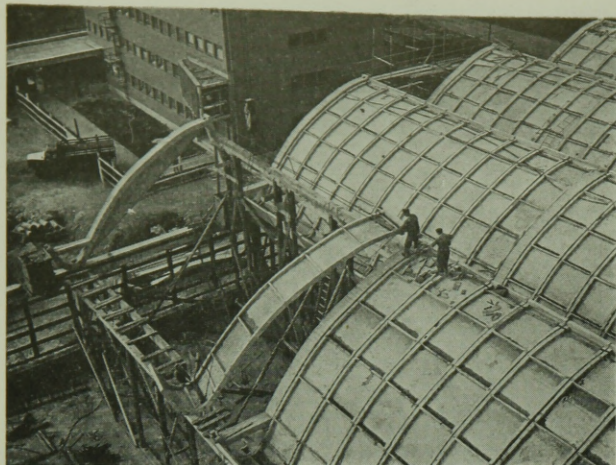
7. ábra. Előregyártott Shed elemek helyszíni illesztése
