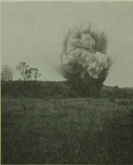
7. ábra. 10 m-es kábeltöltet robbantása. (Szerző felvétele)
