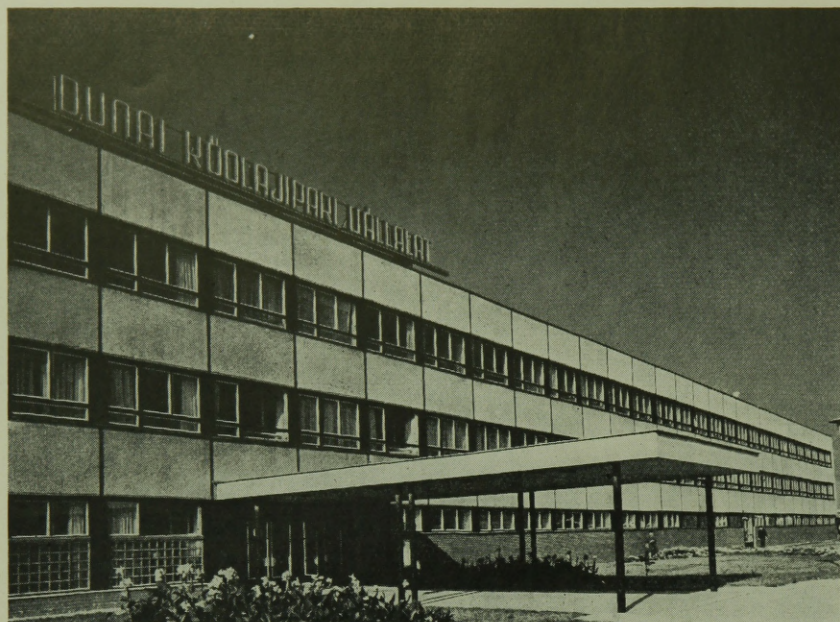
38. ábra. Irodaház üzemben előregyártott típus szerkezettel Tervező: IPARTERV, Gnädig Miklós, Csics Miklós
