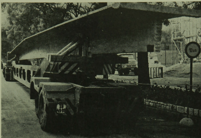
30. ábra. T tartó szállítása
