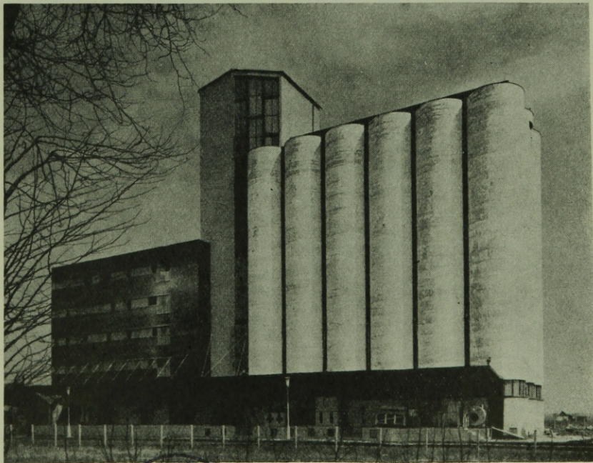
45. ábra. 600 vagonos újszászi gabonasiló. A cella belső átmérője 4,10 m. Tervező: IPARTERV, Garamszegi K., Payer E.
