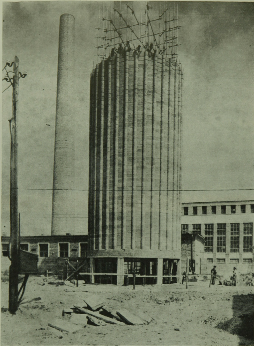
42. ábra. Hűtőtorony (hengeralakú kűrtővel) előregyártott elemekből Tervező: IPARTERV, Homonnai T.
