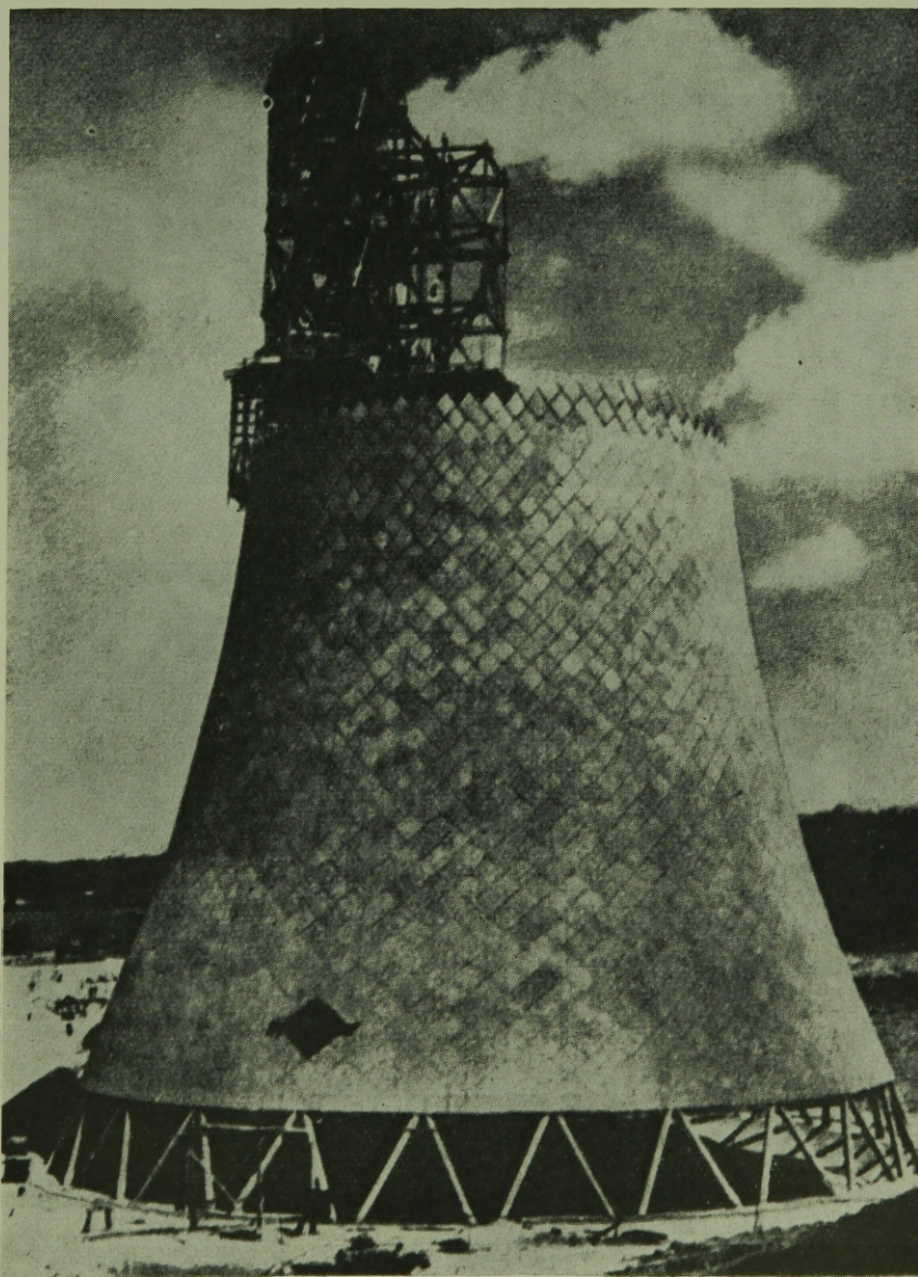
41. ábra. Forgóhiperboloid alakú hűtőtorony, előregyártott elemekből (48 m magas) Tervező: IPARTERV, Mátrai Gy. és munkatársai
