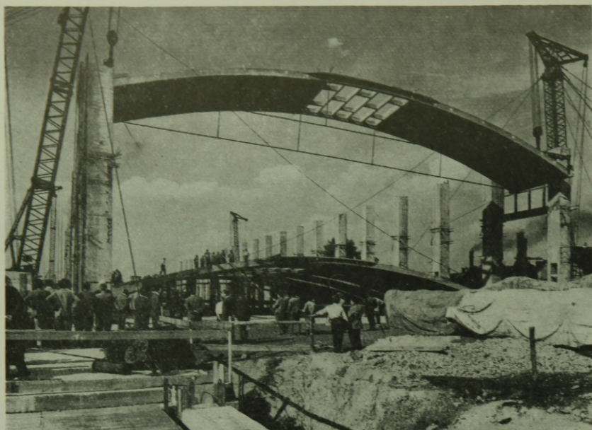
15. ábra. Dongahéj beemelése csőpillérekre, (feszítáv 32 m) Kábelgyár. Tervező: IPARTERV, Mátrai Gyula, Pásztai Károly
