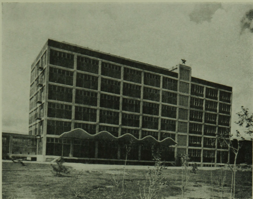
36. ábra. 5 emeletes orosházi magtisztító, helyszínen előregyártott szerkezetekből Tervező: IPARTERV, Zentai Z., Szeleczky F., Emődy A.
