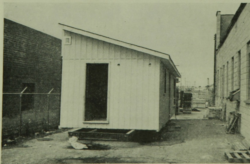
10. ábra. Két darabban előregyártott térelemes faház egyik fele (Kanada)
