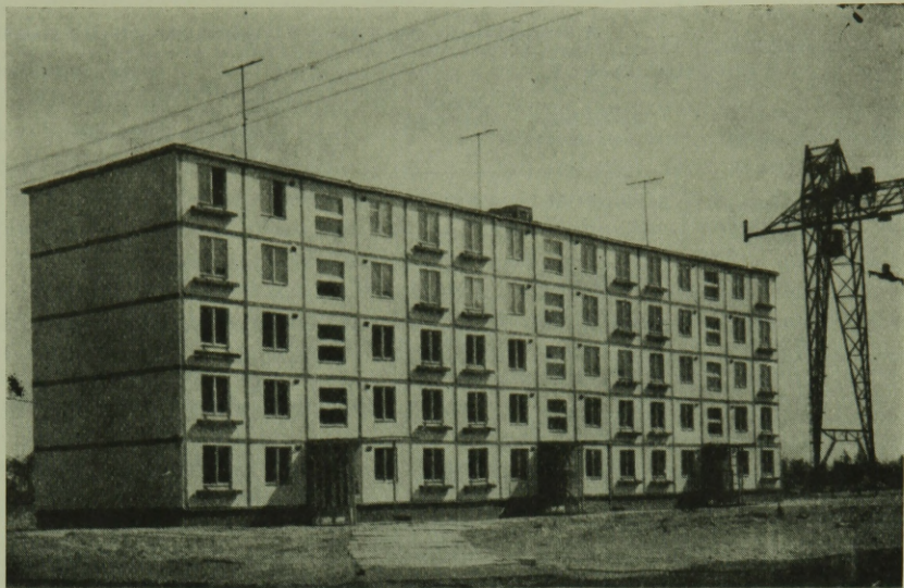
4. ábra. Térelemes lakóépület Moszkvában, a Novije Kuzminki városrészben
