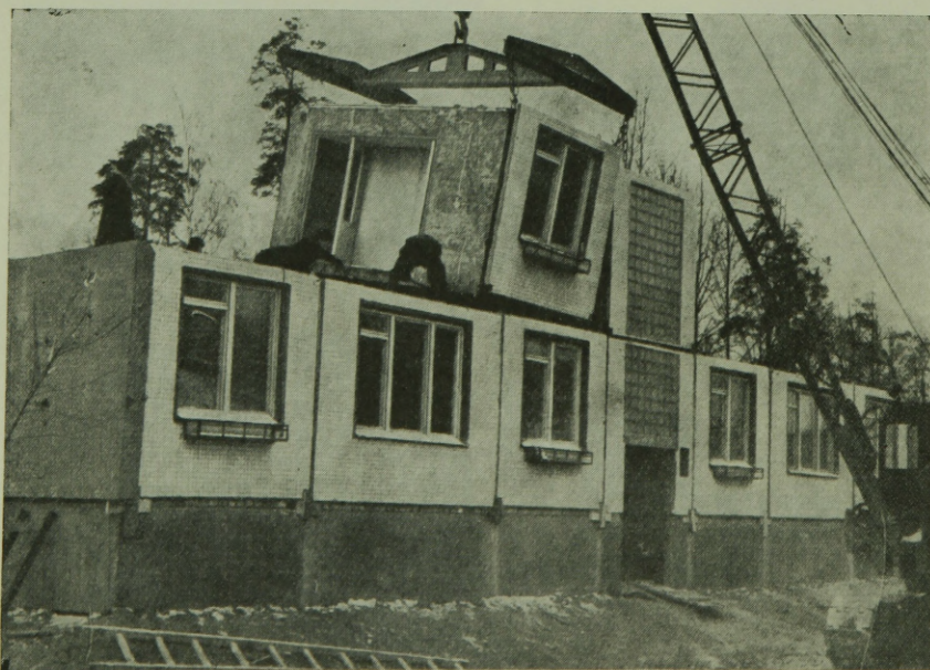
10. ábra. Térelemek szerelése Leningrádban láncfalas daruval
