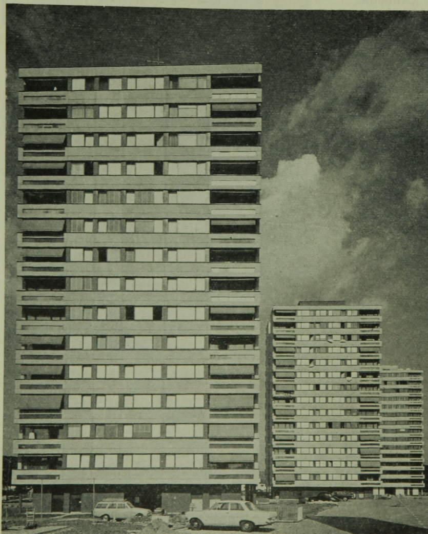
4. ábra. A Zürich, Bändlistrasse-i lakótelep „Allbeton” módszerrel készült pontházai. Az előregyártott homlokzati elemek felülete a nálunk is alkalmazott, ún. mosott kavicsréteggel készült
