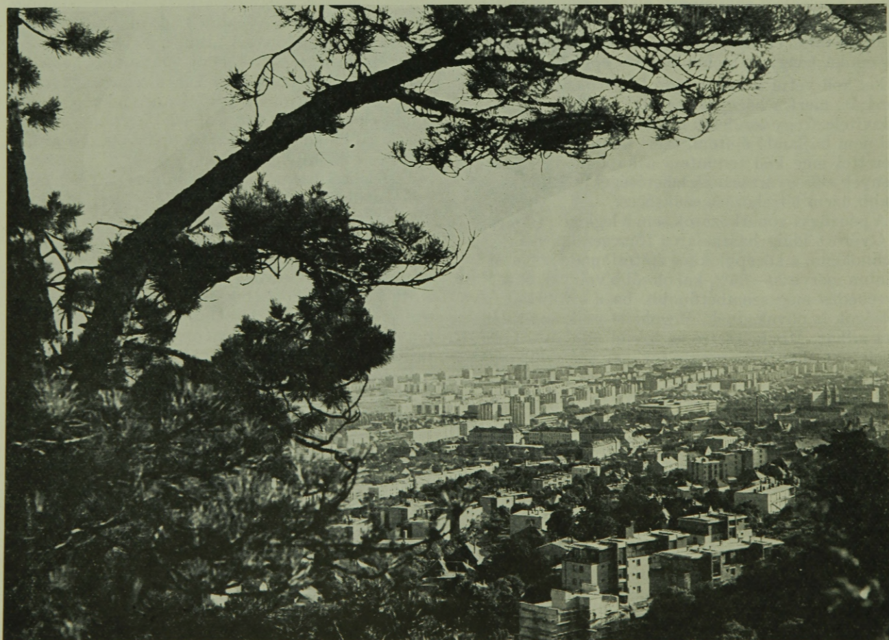
1. ábra. A pécsi Nyugati és Szigeti vr. távlati képe. Előtérben a változatosan tagolt, többfajta nagypanelos épületből komponált, legújabbban felépült és épülőfélben levő együttesek
