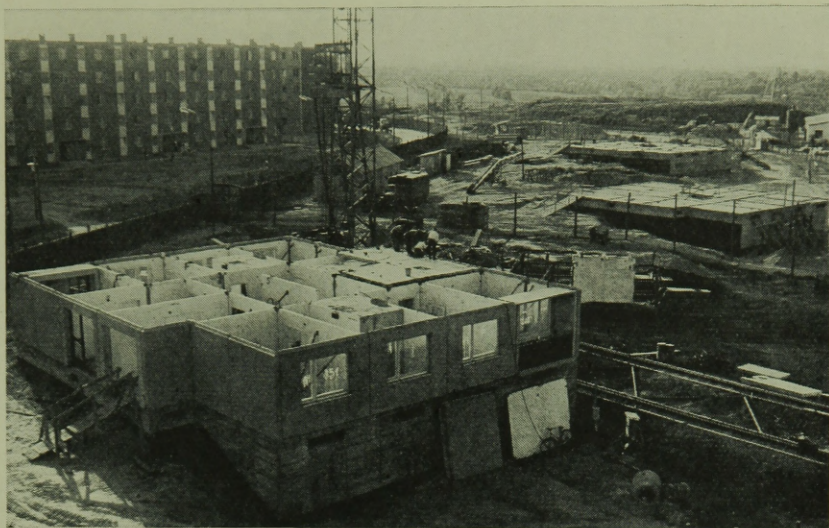
6. ábra. Dunaújváros, Ságvári II. városrész. II. és III. szakasz (MOT. I.58—9/62) Előtérben a C jelű tervcsalád C—P jelű középmagas pontházai, építés közben
