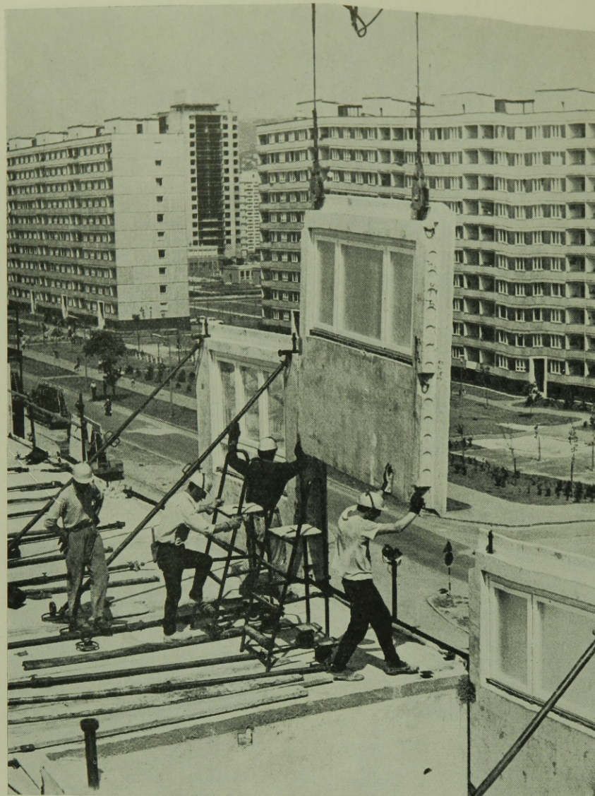
4. ábra. Állítócsavaros, fejlesztett profilú homlokzati panel. Tervező: TTI, 43. sz. ÁÉV. Gyártó: 43. sz. ÁÉV
