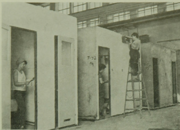
22. ábra. BVM Dunaújvárosi Gyára: Térelemek gyártás közben
