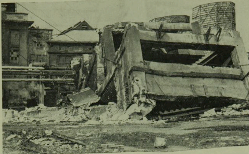
5. kép. „A” épület romjai; a csatlakozó kötelek a „B” épület horgony kötelei
