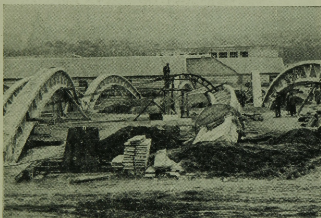
14. ábra. Az ívtartó éléreállítás közben, két végén a vb. ászokgerendára állított forgó gyűrűvel, középen az emelőszerkezettel. Két oldalt a már élére állított ívek, középen ideiglenes oldal-támasszal
