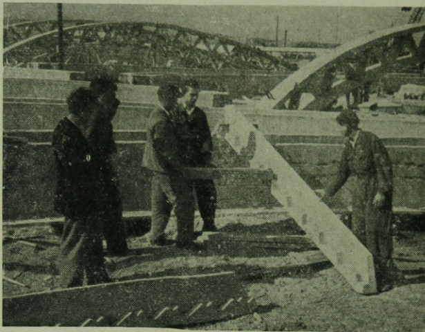
16. ábra. Előregyártott „L” alakú lépcsőfokok és pofagerendák
