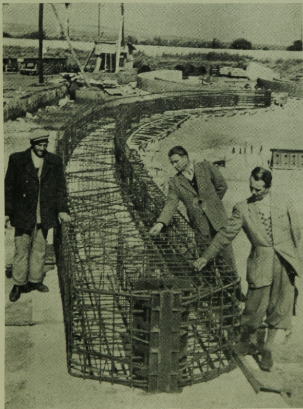
10. ábra. Az ívtartó kész vasszerelése, elől az alsó vassaruval
