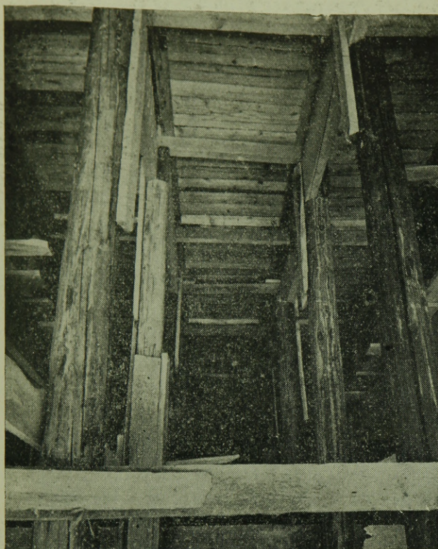
4. ábra. Régi rendszerű alátámasztás lemez zsaluzásnál, a bordák közt két sor dúccal alátámasztott élére állított pallóval.
