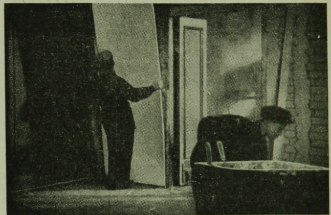
6. ábra. A Peszesánája-utcai lakóház belső vakolása előregyártott lemezekkel
