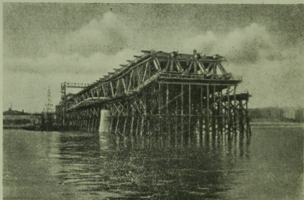
3. ábra. A mederhid szerelésének előrehaladása 1935-ben teljes állványzattal, portáldarukal
