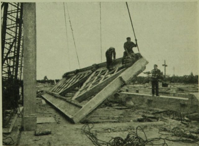
15. ábra. A rácsostartó élére állítása.
