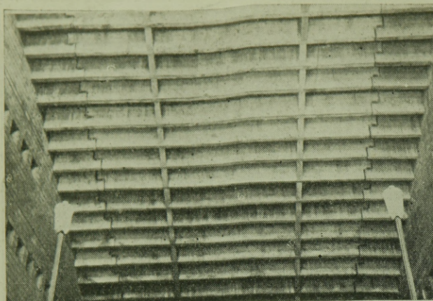
9. ábra. Az előregyártott csuklós ülésgerendázat a merevítő keresztartókkal (Fotó: Balassa Ferenc)
