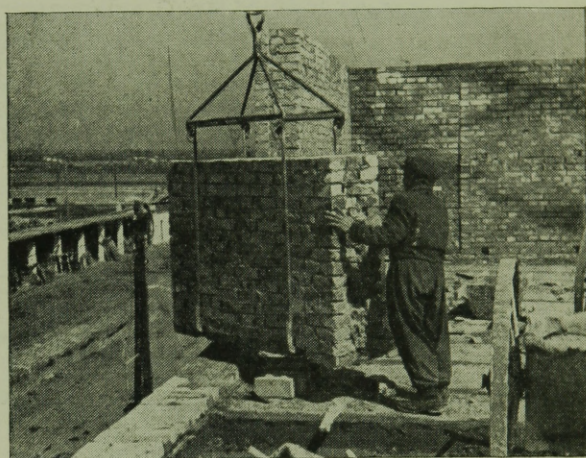
25. ábra. Külső főfal előrefalazott tömbjének beemelése
