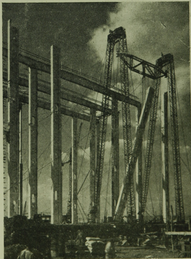
5. ábra. Erőmű építése. (1951)
