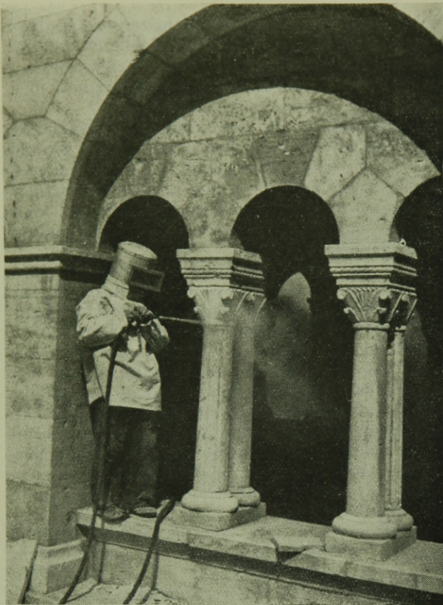
1. ábra. A Halászbástya helyreállítása.
