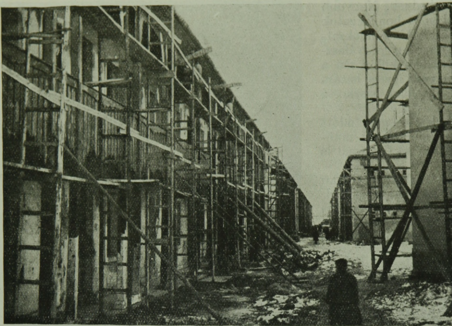
2. ábra. Sortatarozási munkák kivitelezés alatt a Bp. X. Ceglédi-úti munkás-lakótelepen. A kép bal alsó részén jól láthatók a faoszlopok javított talpa. Kivitelező É. M. 42. sz. Építőipari Tröszt.
