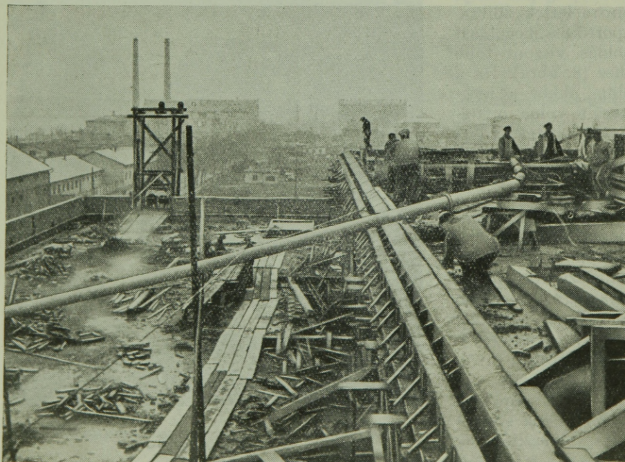
4. fénykép. Betonszállító csővezeték felső vezetése a kitorkolás felé állandó emelkedésben.
