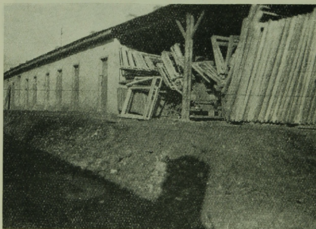
7. ábra. Épületasztalosipari gyártmányok felelőtlen tárolása.
