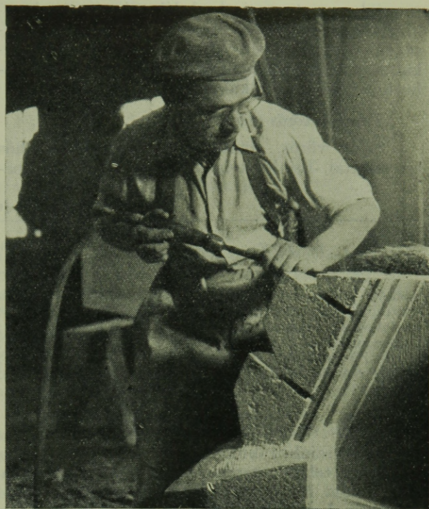
2. ábra. Kőmegmunkálás légkalapáccsal
