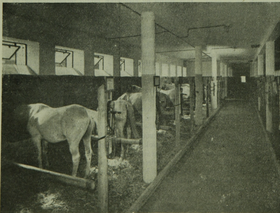
2. ábra. Monolit vb. istálló belső képe.
