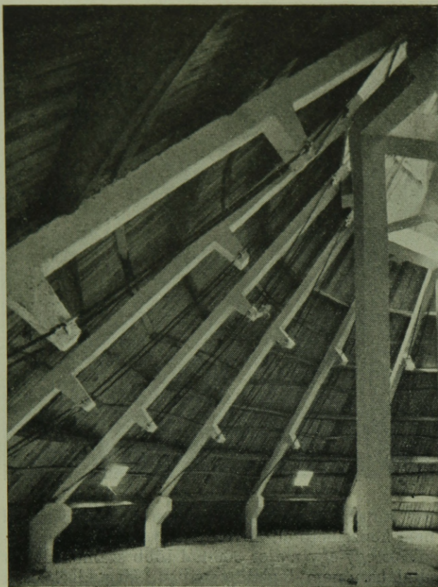
5. ábra. A Sopronkorpácsi répmagtár vb. tetőszerkezete előregyártott szarugerendákkal.
