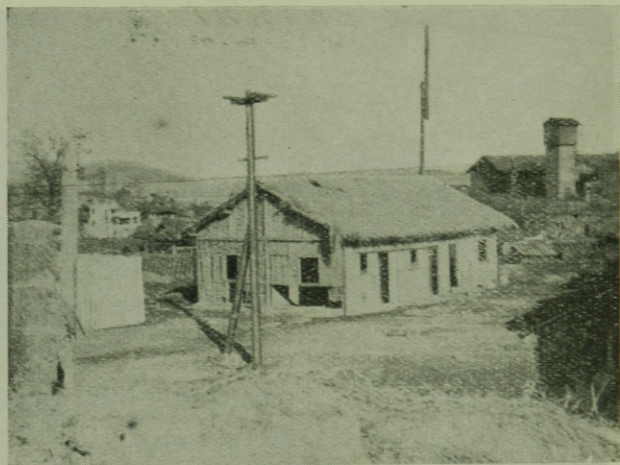
5. ábra. Felvonulási épület, jobboldalt látszanak a magyar Nagykövetség melléképületei
