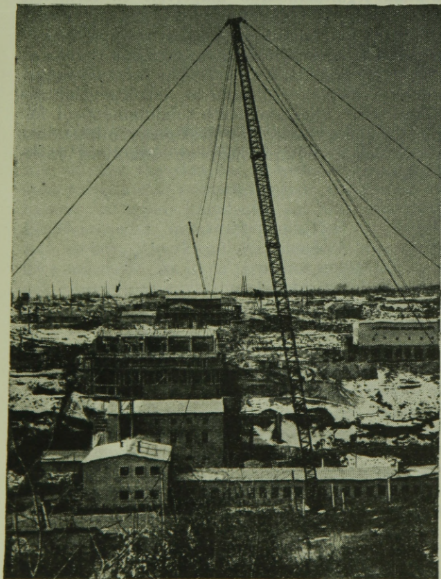
Kábeldaru a gyöngyösoroszi építkezésen
