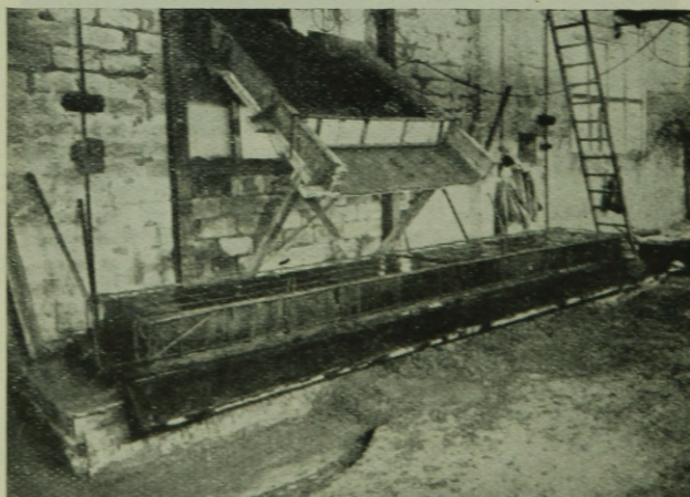
4. ábra. Beszerelt panelsablon a vibráasztalon történő betonozás előtt
