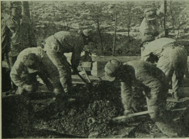
2. ábra. A Phenjan-i új színház földemének betonozása, háttérben a város
