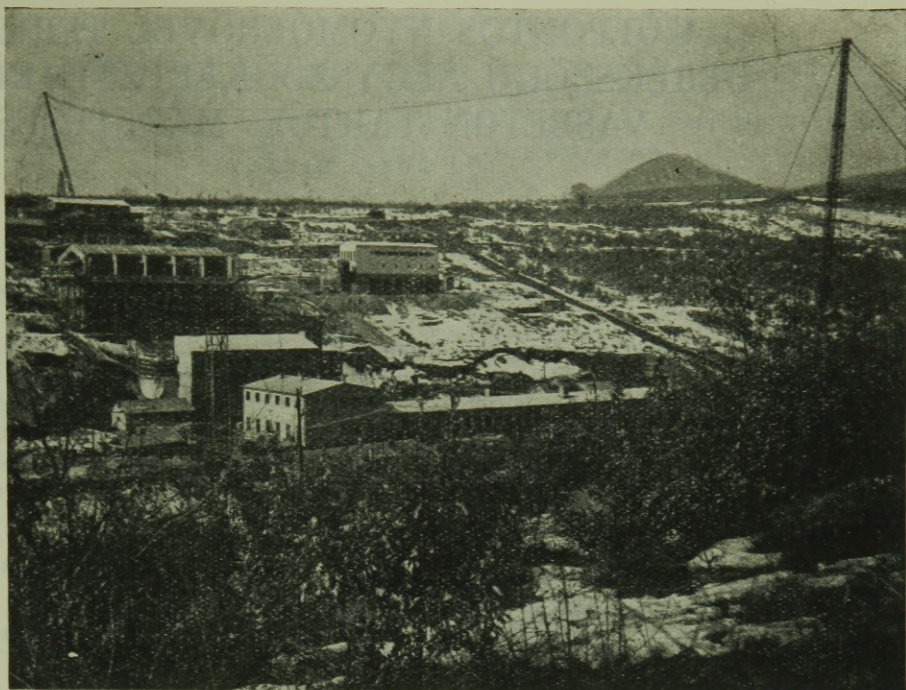
Kábeldaru a gyöngyösoroszi építkezésen
