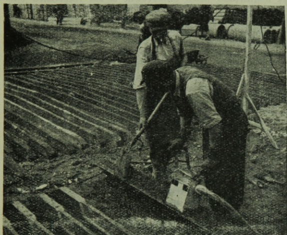
19. ábra. Miskolci üzem zárt, de perforált fenék lemezű buktató sablonja és bedolgozási módszere
