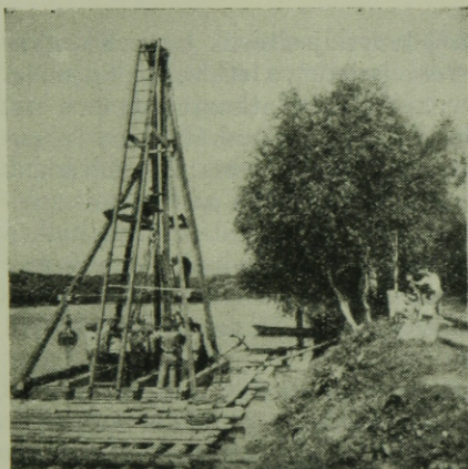
5. ábra. Fatutajról kézi istrángos cölöpverési munka. Vízijármű és gép hiányában az olcsóbb munkaerővel lett elvégezve a nehéz cölöpözési munka (1940)
