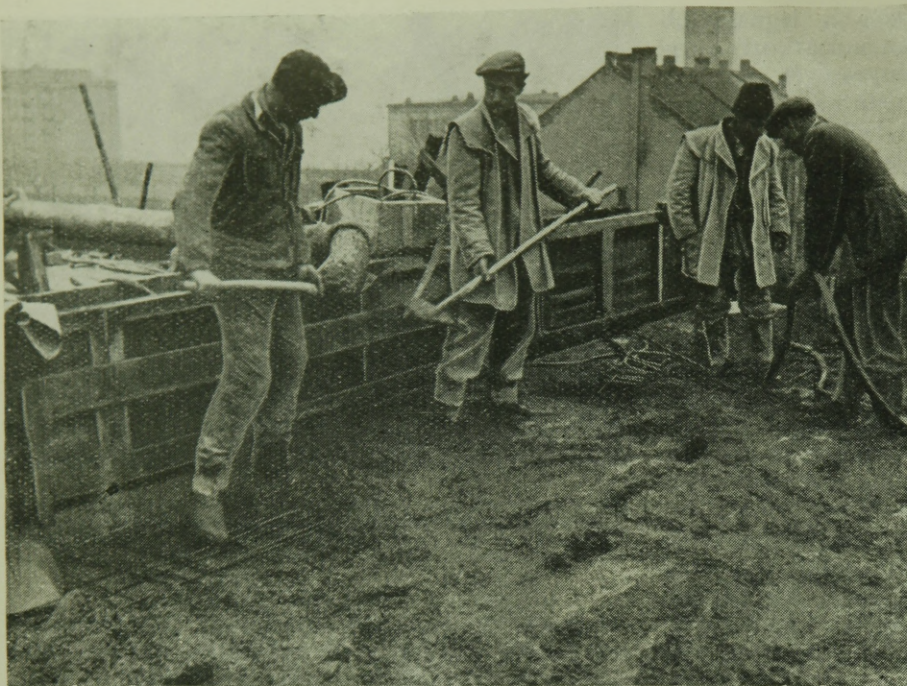
9. ábra. A nedves keverék a csővezeték segítségével az épület azon helyére kerül, ahol szétosztás után azonnal be lehet vibrálni (1952)
