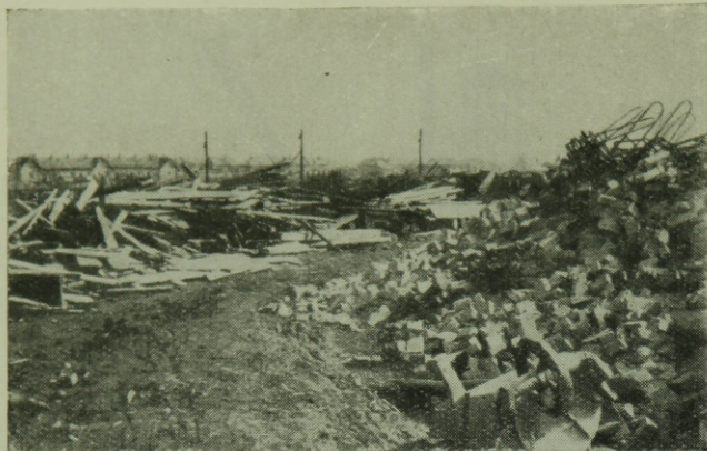
14. ábra. Az a munkahely, ahol az építési anyagok „rendjét” így találják, ott nemcsak munkaigényesség csökkentéséről, hanem anyagtakarékosságról se lehet beszélni (1954)
