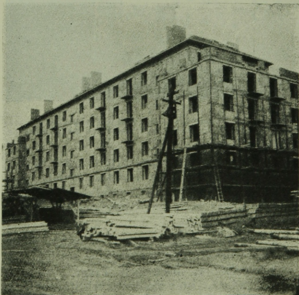
18. ábra. Előrefalazott téglatömbökkel épített lakóház Mosz-Podrateckán.
