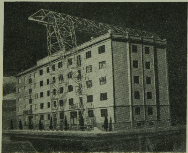
20. ábra. A Gottwaldovi „G”-jelű kísérleti épület és a szereléshez legyártott különleges emelőszerkezet modellfényképe.
