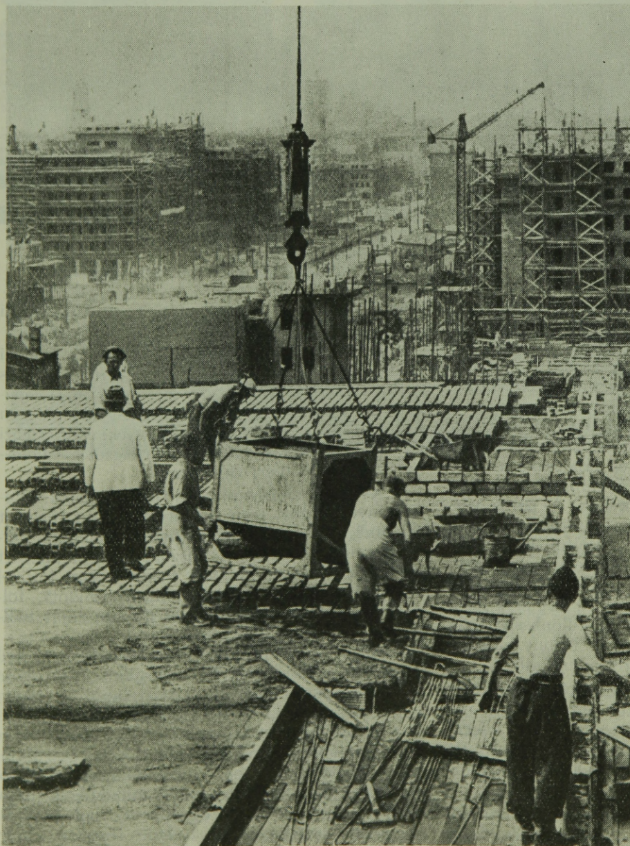
3. ábra. A nagyépítkezés színhelye.
