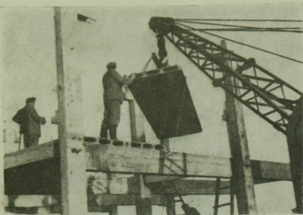
29. ábra. Előregyártott lakóépület szerkezete. Födémelem beemelése.
