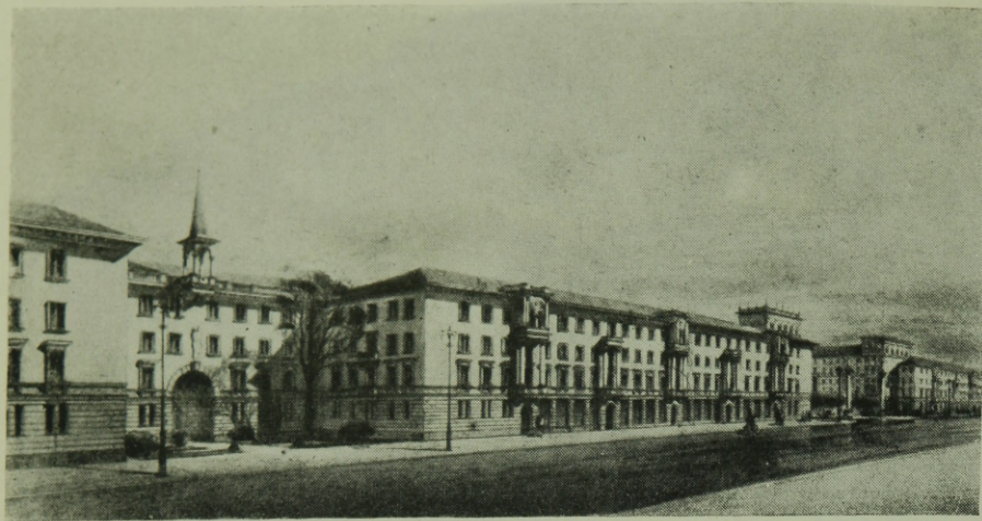
5. ábra. Dimitrovgrád. vasút melletti út.
