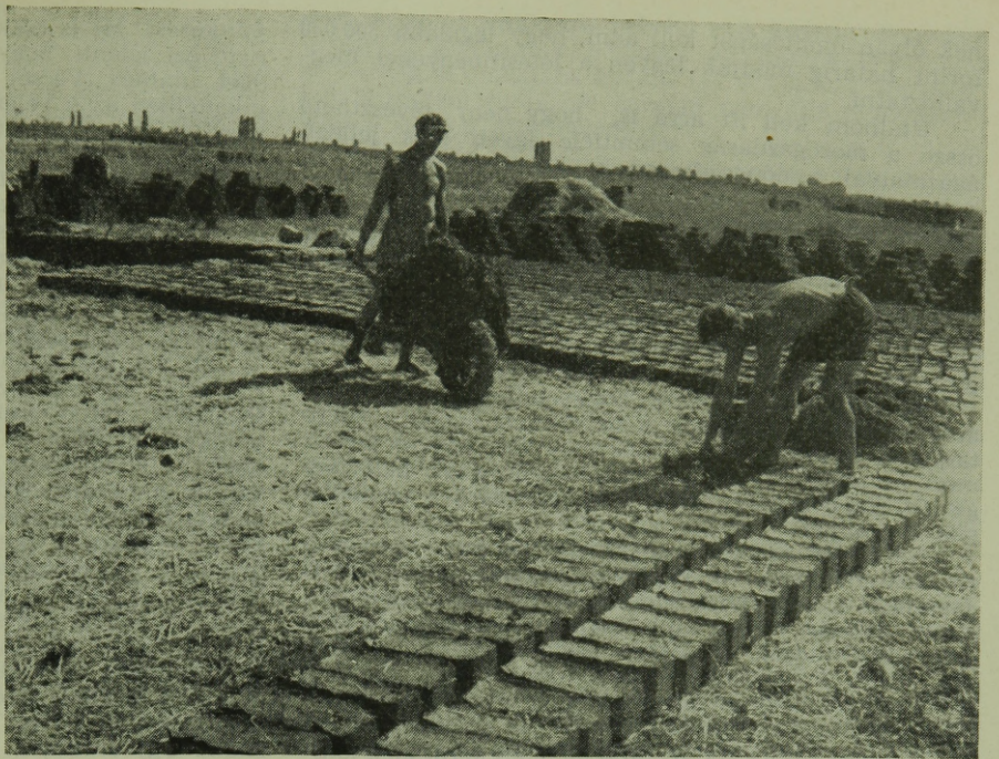
4. ábra. Vályogvetés lakóházak építéséhez.
