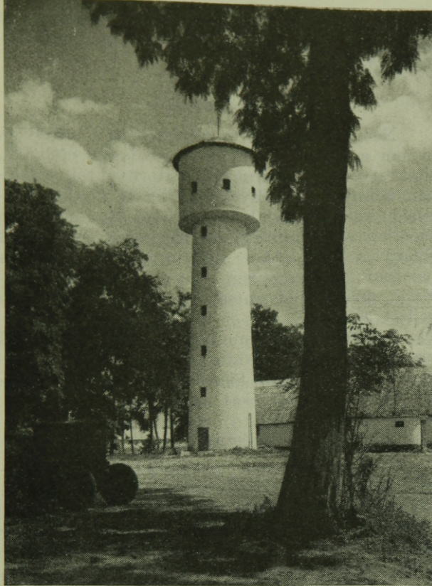
1. ábra. Állami gazdaság víztornya.
