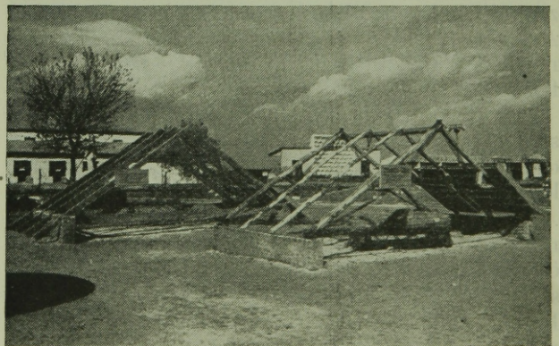
7. ábra. Hulladékdeszkából szegezett vonódeszkás fedélszék. Mezőgazdasági gömbfából és hulladék perforált lemezből készült utófesztethető fedélszék.
