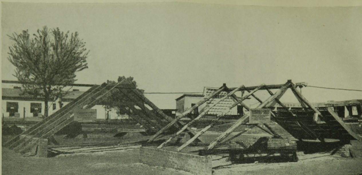
4. ábra. Hulladék vaslemezéből és lombos rúdfából készített, feszített fedélszék. Balra rövid deszkából készült, szegezett fedélszék.
