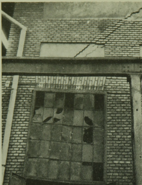
3. ábra. A talajduzzadás a gépcsarnok sarkát is megemelte, az esőlevezető csatorna alatt. A falak megrepedeztek.
