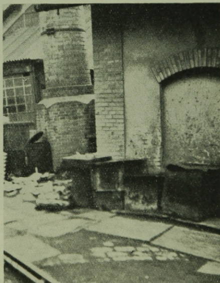
2. ábra. A duzzadás következtében a talaj 40 cm-rel megemelkedett és a gyárkéményt az olvasztókemencével együtt a függőleges vonaltól 11°-kal eltolta.
