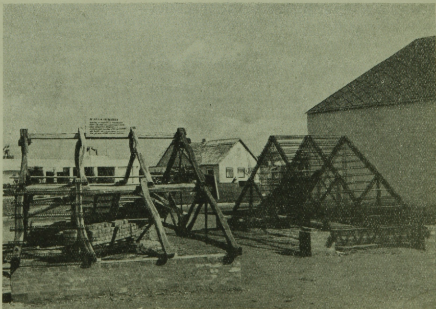
3. ábra. Hulladék vaslemezről és rövid lombos fából készült fedélszék, perforált lemez lécezéssel. Jobbra teljesen perforált hulladék vaslemezről készült fedélszék.
