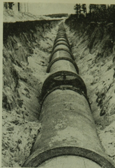
12. ábra. Elkészült csőszakasz Vianini csövekből, légszeleppel.
