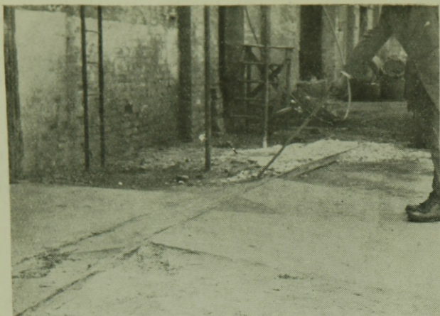
6. ábra. A betonnal letakart szennyezett talaj megemelte a sínpálya egy szakaszát, melyre állandóan csöpög a tetőereszről a csapadékvíz.
