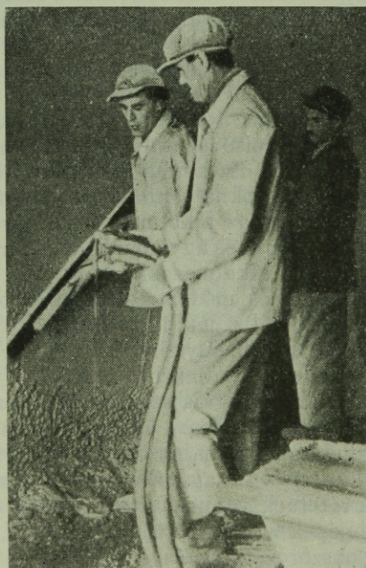
2. ábra. Az alapvakolat felhordása és eldolgozása.
