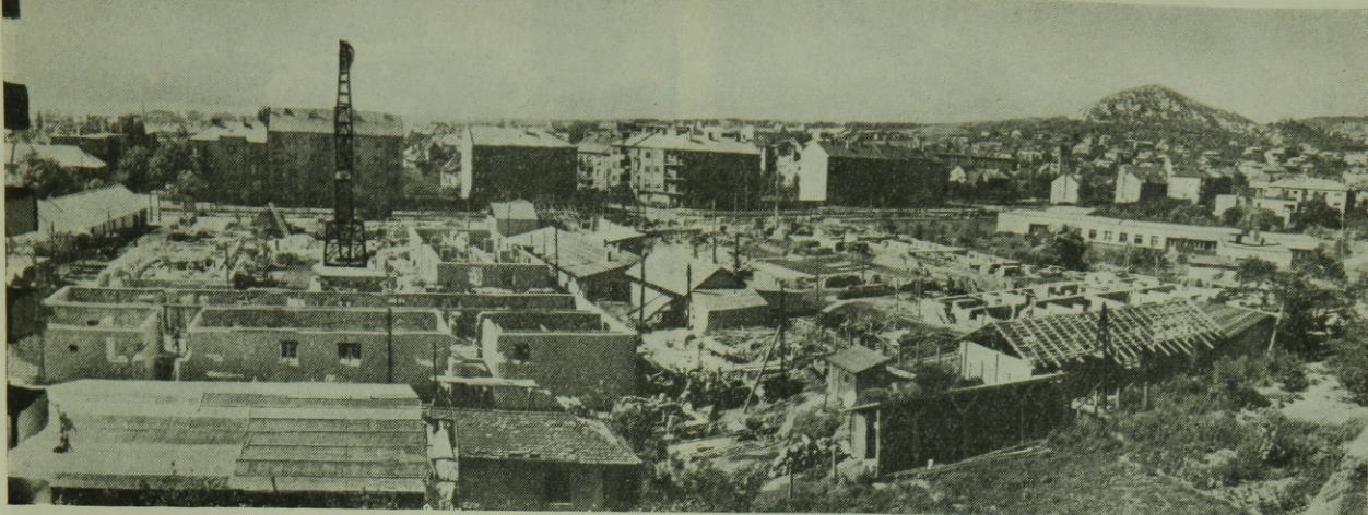
2. ábra. Az építési terület a Gellérthegy felől nézve, 1953. szeptember elején, tehát a tényleges munkakezdés után 5 héttel. A gyors földmunkát az exkavátor tette lehetővé. A Villányi út túlsó oldalán 3 emeletes, rendszertelen, régi foghíjas beépítés látható. Jobbszáron a Sashegy kúpja.
