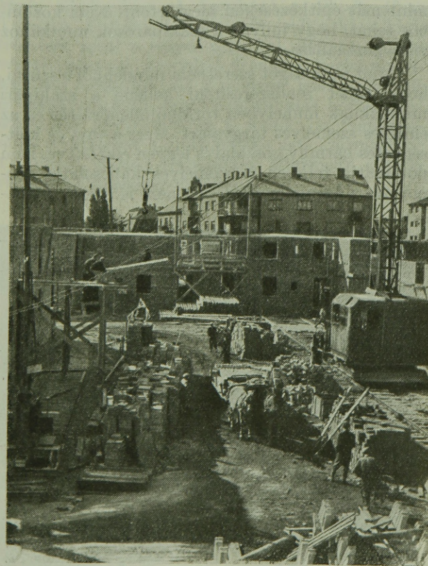
9. ábra. Előregyártott födémgerendák szállítása és beemelése.
