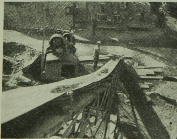
4. ábra. A géppel kevert betont a szállító-szalag viszi az emeletre.
