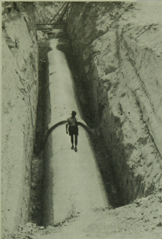
4. ábra. Turbina-ejtőcső árkanak kiemelését és visszatöltését a nagy földmunka miatt csak géppel célszerű végezni
