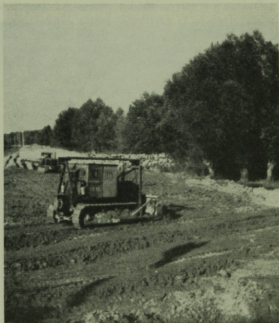
6. ábra. A dömperek által hordott földet a tologép elegyvengeti
