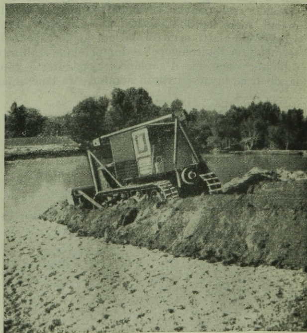
2. ábra. Buldozer gátépítés közben
