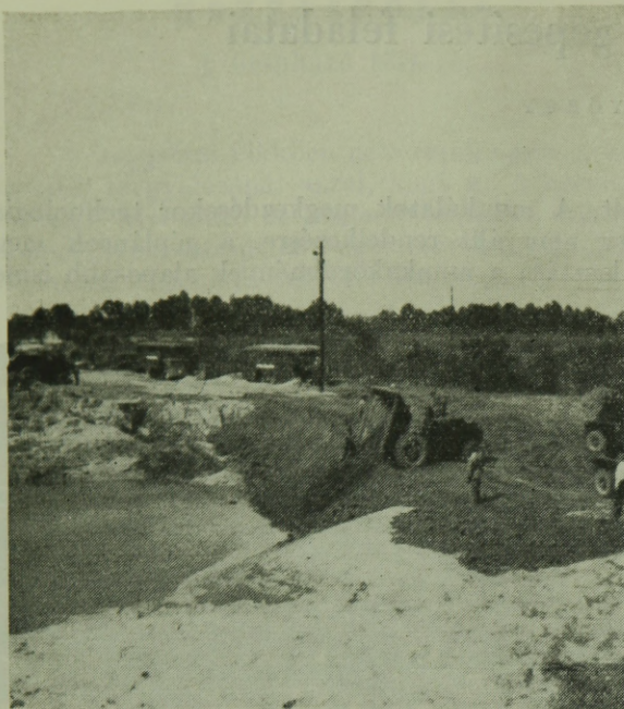
3. ábra. A dõmperek közvetlenül a gátba ürítenek
