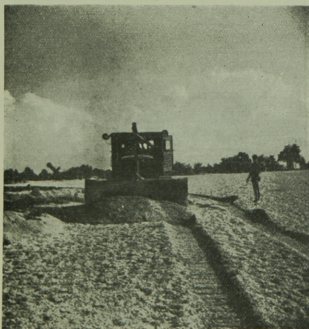
8. ábra. A hordalék kavicsmezők visszatolása
