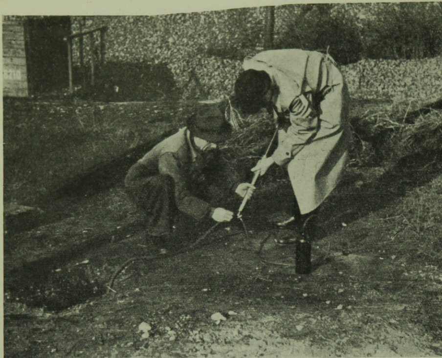
4. ábra. Talaivíz minta vétel kéziszivattyús vízmintavevővel
