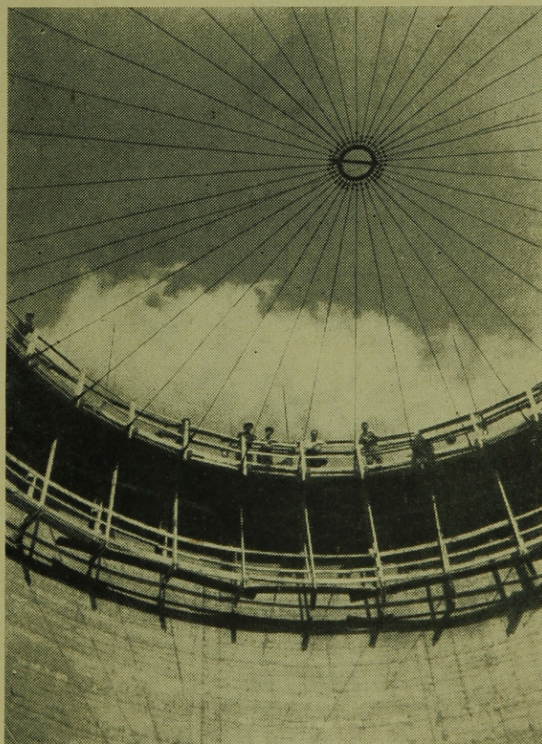
7. ábra. Hűtőtorony csúszószaluzása.
