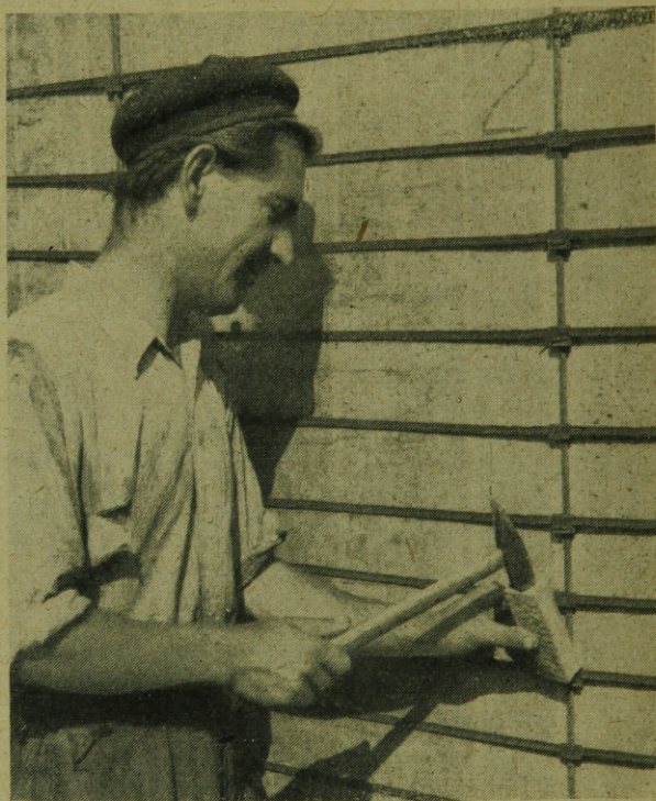
3. ábra. 300 m 3 -es folyadéktartály acélhuzalainak feszítése.
