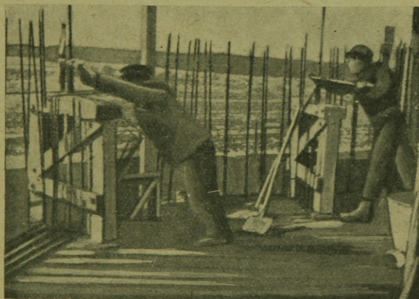
7. ábra. Csúszózsálatás felhúzása kézi erővel, csavarorsó segítségével.
