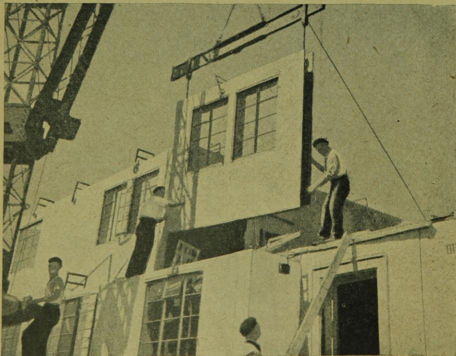
5. ábra. Angol nagy panelek szerelése.
