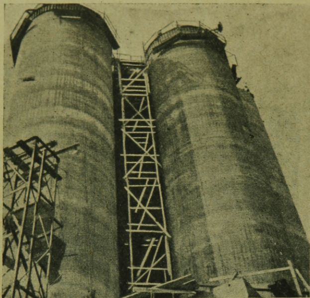
14. ábra. Hat siló, mindegyik 30 méter magas és 7 méter széles; acélzsaluzat.
