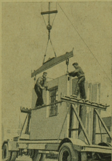
4. ábra. Angol nagy panelek szállítása.
