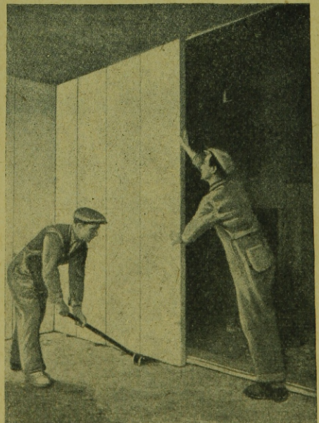
3. ábra. Siporex belső falpanel.
