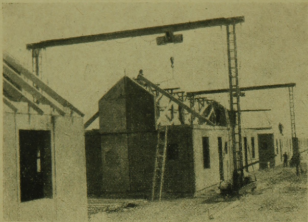
15. kép. Az oromfalpanelek és a feszített vb. szaruk szerelése.
