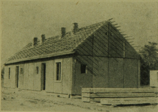
17. kép. Az ikerház udvari homlokzata a lécezés után.
