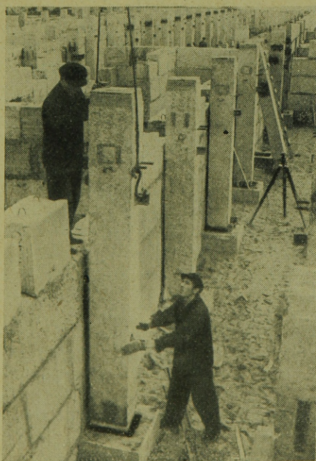
3. ábra. Pincepillérek és falak szerelése.
