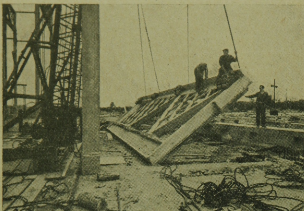
18. ábra. Ablaktartók élreállítás a II. ütemben.
