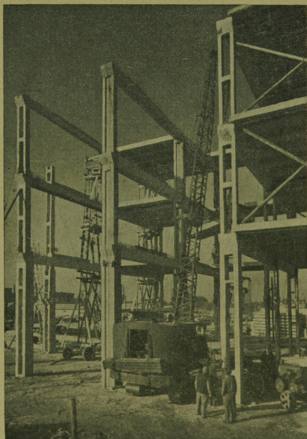
27. ábra. Mestergerendák és födémpanelek elhelyezése.
