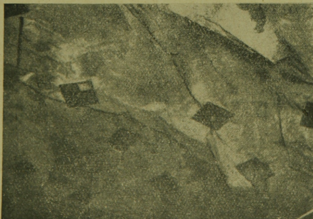
4. ábra. A Forcacava-i gépházcsarnok főtéjének biztosítása horgonyzással.
