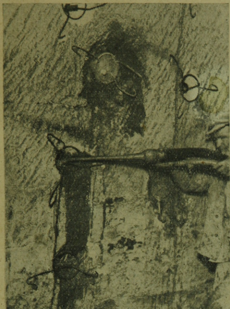
11. ábra. Budapesti sziklapince vasbeton horgonyának kitöltése, torkretező cső fokozatos visszahúzásával.
