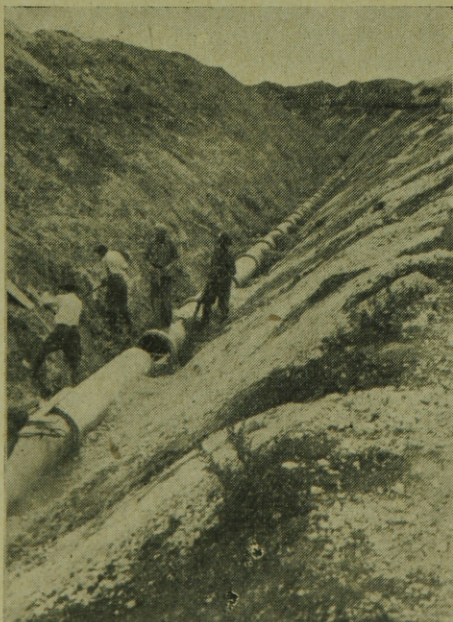
1. ábra. Vasbetoncső munkaárka (Péti tápvezetecsatorna).
