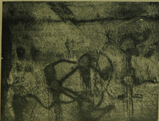
13. ábra. Budapesti sziklapince függőleges falainak megerősítése előregyártott vasbeton horgonyokkal.
