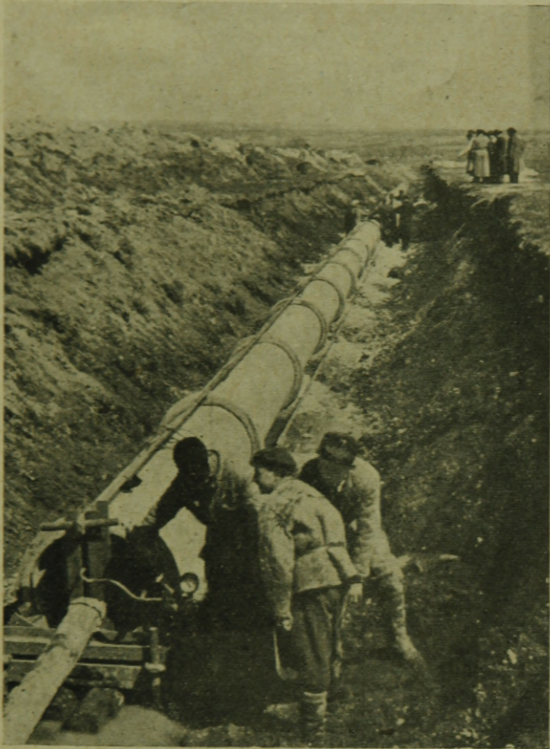
7. ábra. Kísérleti csővezeték-szakasz nyomáspróbája. A csövet elzáró lemez dugót három szál vonórúd fogja össze.
