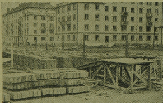
1. kép. Tégladepónia áthelyezhető rakodóplatóval, a téglák 50 db-os konténerizált egységekben.
