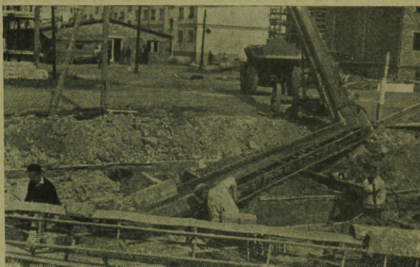
7. kép. Pincetömb kiemelés kapcsolt szállítószalagokkal.
