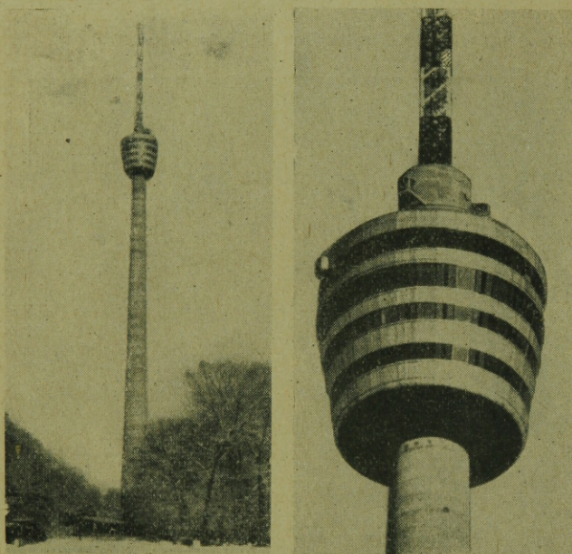
8. ábra. A stuttgarti televíziós torony fényképe. 9. ábra. A stuttgarti televíziós torony „kosára”.
