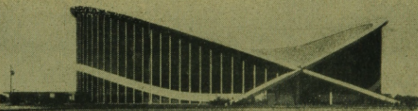
5. ábra. A Raleigh-i sportcsarnok feszített háló fedélszerkezettel.
