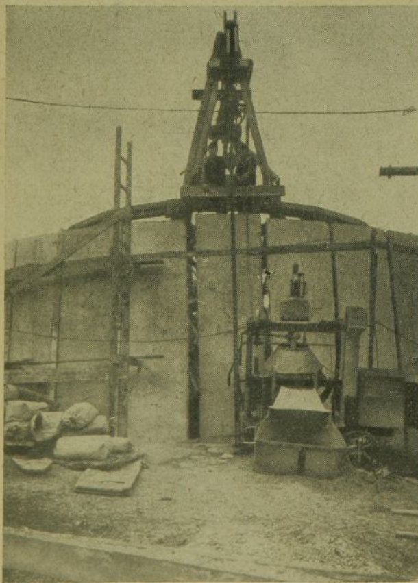
4. ábra. Az oldalfal-elem elhelyezése
