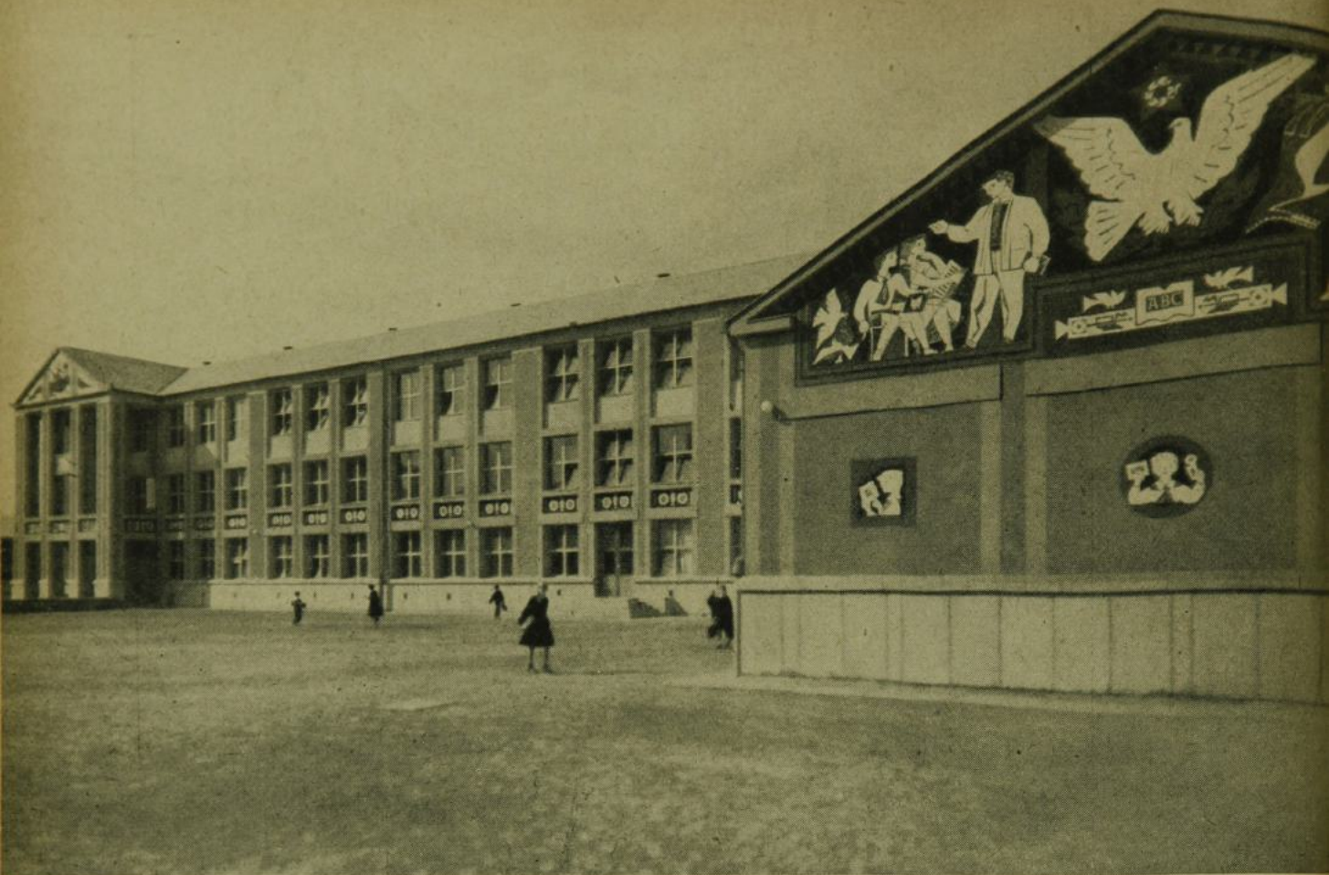
1. ábra. Gubacsi híd fő, iskola. Tervező: Pintér Béla (Közt)
