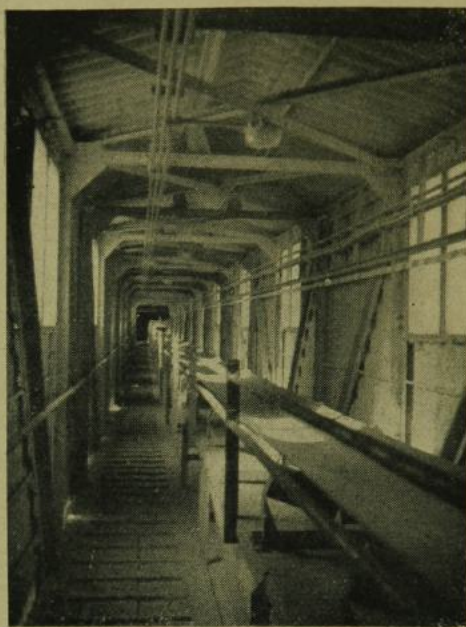
2. ábra. Szállítószalag-folyosó belső képe
