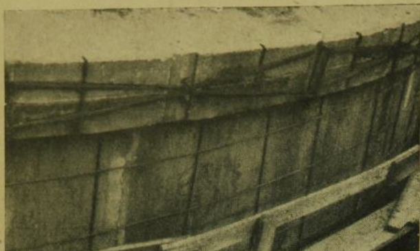
9. ábra. A kupola-gyűrű, a harántirányban feszített kábelekkal
