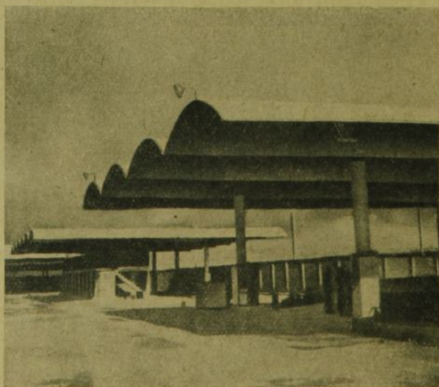
1. ábra. Hajlított dongahéj, konzolos, négyoszlopos megoldással
