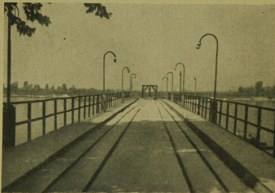
2. ábra. A szőnyi kikötőhíd pályaszerkezete
