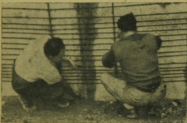
10. Feszítés, a csonkakúp alakú oldalfalra tekercselt huzalok leverésével. A huzal útját a kezuijak mutatják
