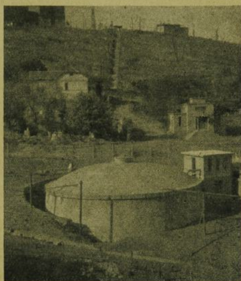
14. ábra A víztartály képe az építés befejezése után
