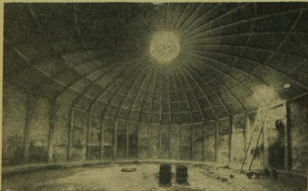
12. ábra. A befejezés előtt álló tartály belső képe
