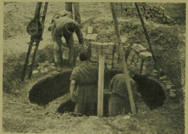
8. ábra. A törekes vályogtéglaával készített kút (I. szám)
