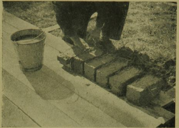
6. ábra. Vályogtéglaák verése
