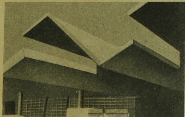
3. ábra. Z-alakú séd-tető, kéttámaszú, konzolos megoldással
