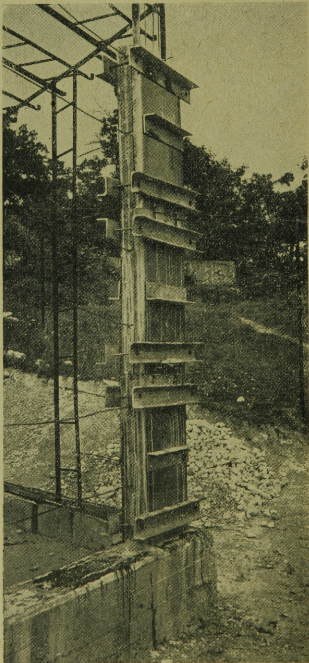
16. ábra. Alumínium zsaluzással készült beton oszlop
