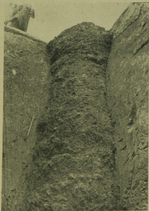
10. ábra. Klászott betoncölöp
