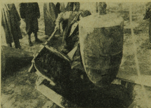
6. ábra. Cölöp betonozás
