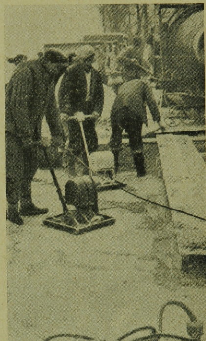
4. ábra. Pallóbetétes híd betonjának tömörítése
