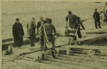
3. ábra. Pallóbetétes híd betonozása
