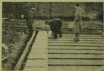
6. ábra. Födémlemez feszítettbeton lemezbetétek és Siporex gázbeton tömbök alkalmazásával
