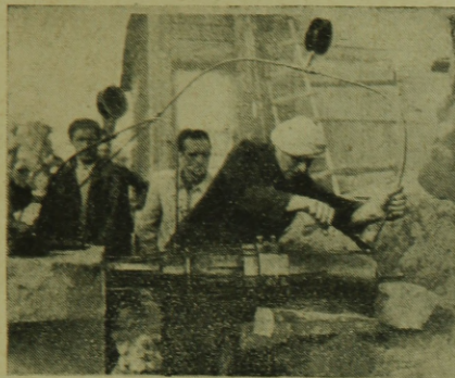
11. ábra. Hídfőtartó feszítése TK típusú sajtóval
