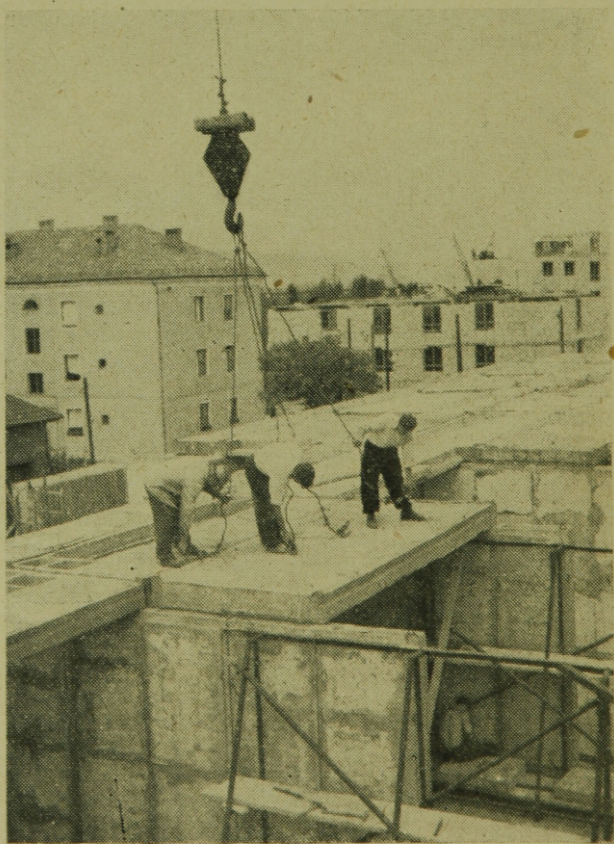
1. ábra. Gubacsi úti K 2 épület födémpaneljei
