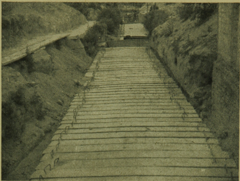
10. ábra. Lefedett védőcsatorna szakasz
