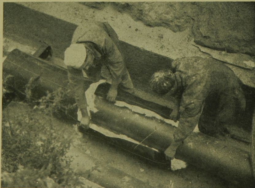
8. ábra. Csővezeték szigetelése
