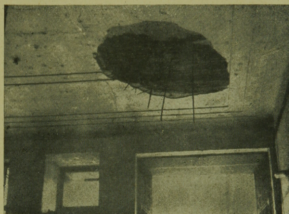
6. ábra. Födémtest táskásodása
