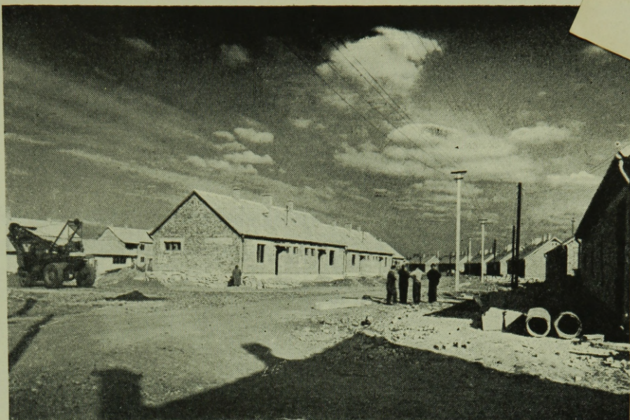
Edelény. A kenderföldi (A-jelű) területen épülő földszintes lakóépületek egy része (déli íves utca képe). Tervező: Bányászati Építő V. Tervező Részlege, kivitelező: ÉM. 21. sz. Á. É. V.
