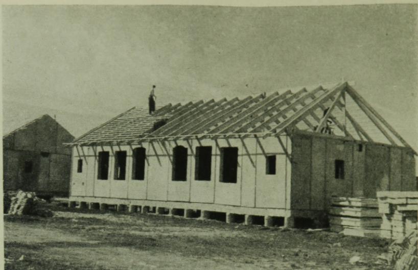
Kazincbarcika. A tetőszerkezet előregyártott vb. szarugerendákkal készül. Tervező: Építéstudományi Intézet, kivitelező: KPM Betonútépítő Vállalat
