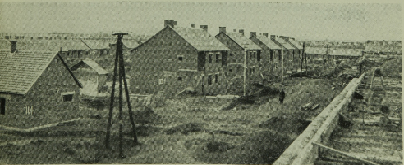
Kazincbarcika. A VII. szomszédsági egységben 1957 évben épült 150 lakás. A földszintes épületek egy része hagyományos építési móddal épült, később — mikor elkészült az előregyártó telep — nagyfokú előregyártással. Tervező: Építéstudományi Intézet. Kivitelező: KPM Betonútépítő V.
