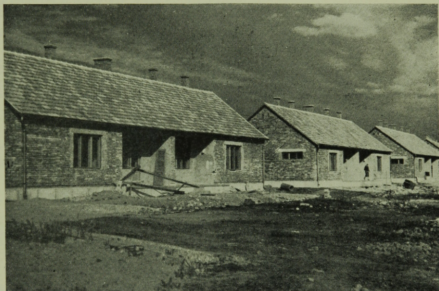
Edelény. A kenderföldi (A-jelű) terület déli részén épülő földszintes lakóépületek udvari homlokzata. Tervező: Bányászati Építő V. Tervező Részlege, kivitelező: ÉM. 21. sz. Á. É. V.
