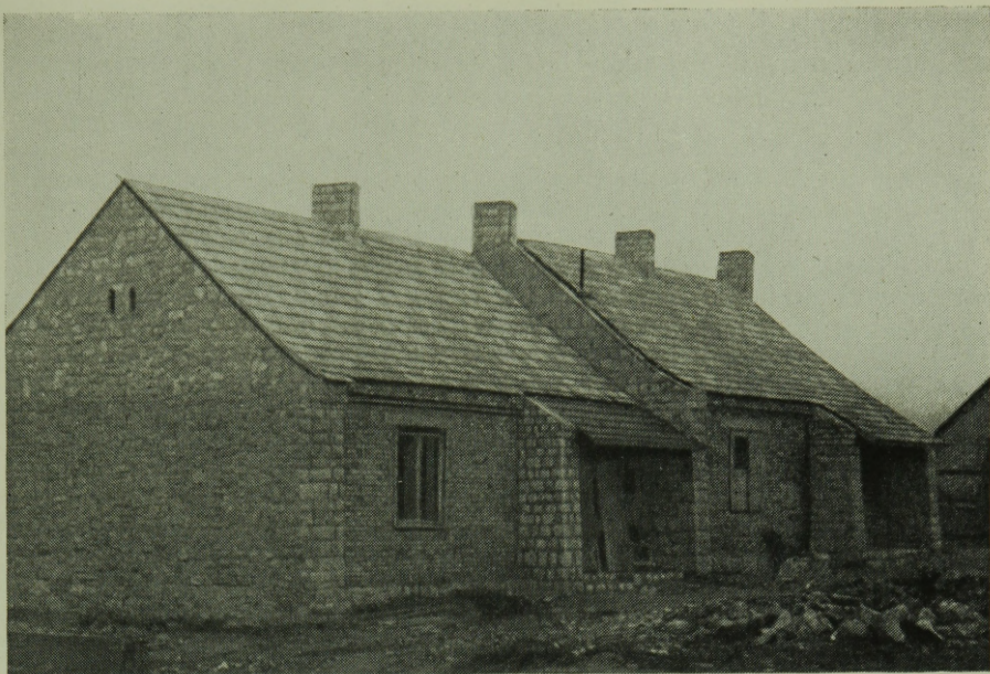
Zirc. Lépcsőzetes padlószintű eltolódással épülő ikerlakóház, természetes burkolattal. Tervező: Győri Tervező Iroda, kivitelező: EM. Győrmezei Á. E. V
