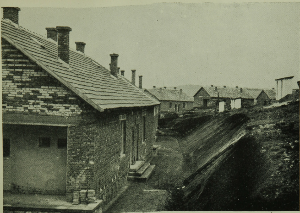
Rudolftelep. A földszintes ikerlakóházak udvarán jelentkező bevágás. Jobbra láthatók az ideiglenes árnyékszékek. Tervező: Bányászati Építő Vállalat Tervező Részlege, kivitelező: Bányászati Építő V.
