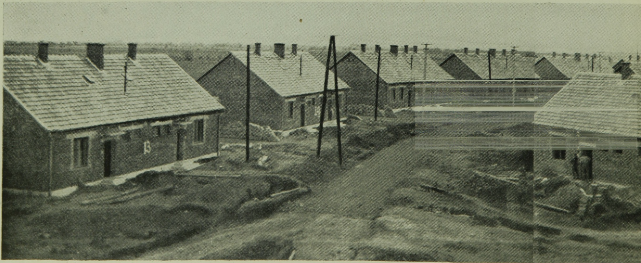
Edelény. A Kenderföldi (A-jelű) területen épült földszintes és egyemeletes épületek egy része. Tervező : Bányászati Építő V. Tervező Részlege, Mélyépterv , kivitelező : ÉM. 21. sz. Á. É. V.
