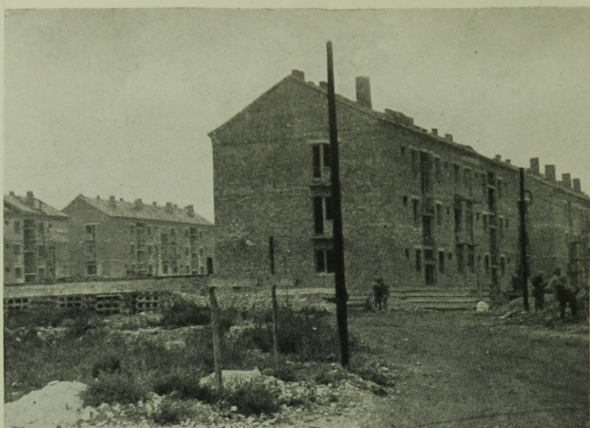
Várpalota—Tés-i domb. Épülő emeletes lakóépületek. Tervező: LAKÓTERV, kivitelező: ÉM. 26. sz. Á. É. V.
