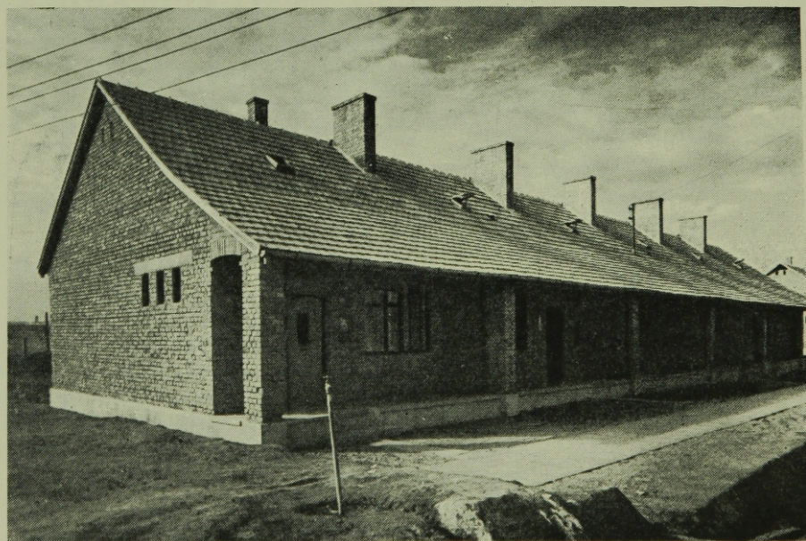
Edelény. A kenderföldi (A-jelű) területen, a Miskolci Tervező Iroda B-jelű sorozatterve szerint épült sorház. Tervező: Bányászati Építő V. Tervező Részlege, kivitelező: ÉM. 21. sz. Á. É. V.
