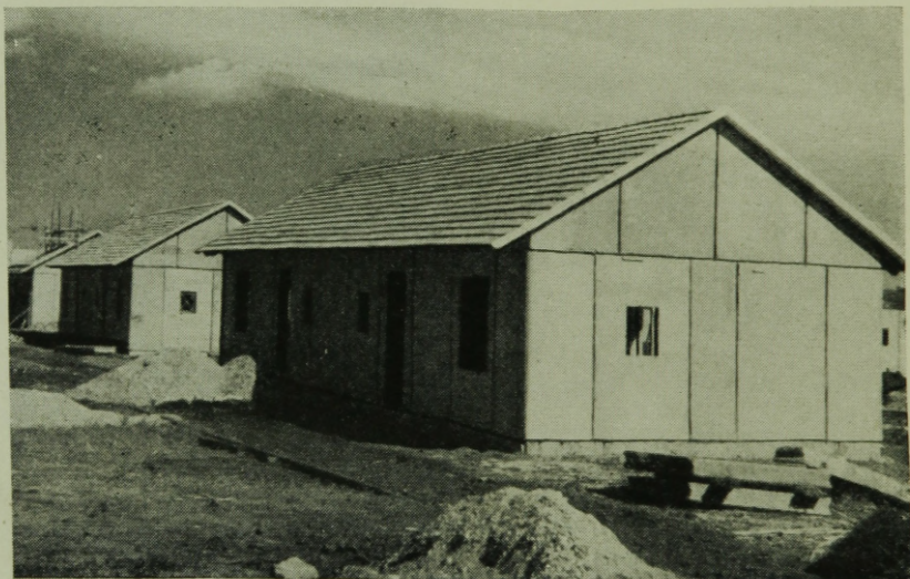
Kazincbarcika. Nagyfalú előgyártással épült földszintes iker lakóépületek. Tervező: Építéstudományi Intézet. Kivitelező: KPM Betonútépítő Vállalat.
