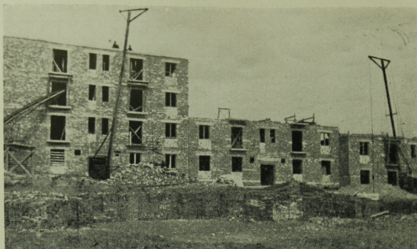
Komló. A kenderföldi többszintes lakóépületek jó munkaszervezés mellett épülnek. A képen látható, hogy egy épülettömbön belül a háromszekciós lakóház — helyesen — lépcsősen épül. Tervező: Lakóterv — Pécsi Tervező Iroda. Kivitelező: ÉM. Bácsmegyei Á. É. V.
