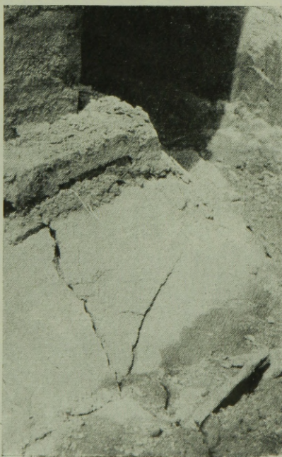
3. ábra. Teherelosztó betonzsámoly nagyobb részének elbontása után visszamaradt rész a megnövekedett igénybevétel következtében magától szétrepedezik
