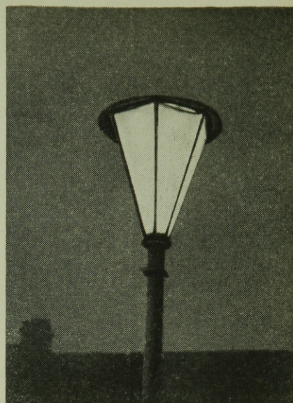
5. ábra. Az első hazai kísérleti lágyvasbetétes közvilágítási lámpaoszlop
