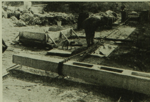
4. ábra. Nagycsúshúzású oszlop próbatörése padban
