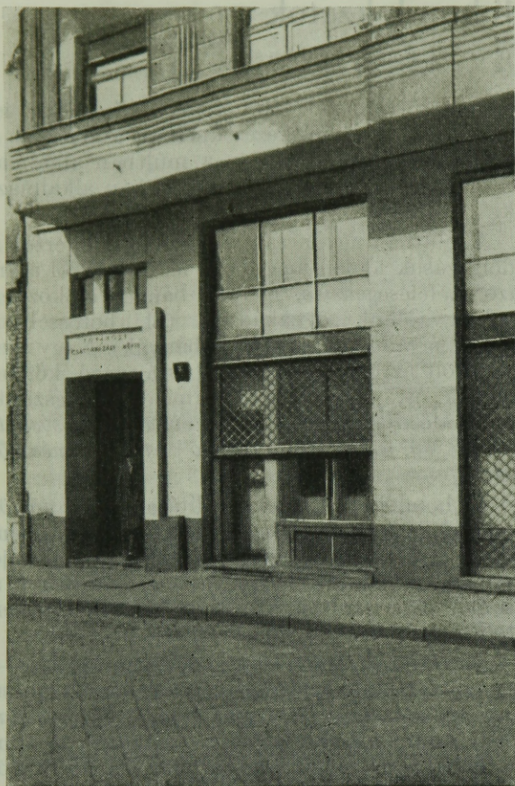
1. ábra. Kapu körüli nagyrészt tönkrement szienit burkolólemezek átcsoportosítása, kiegészítése travertinnal.
