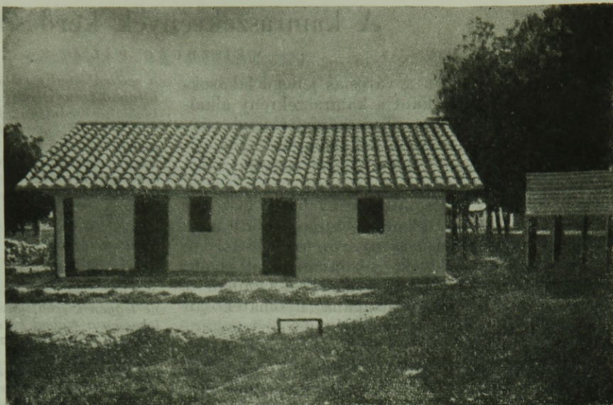
1. Cinva-Ram blokkokból épült falusi ház
