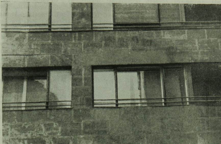
2. ábra. Mártírok útja 15—17. sz. Durva mészkőburkolat pótlása vakolattal
