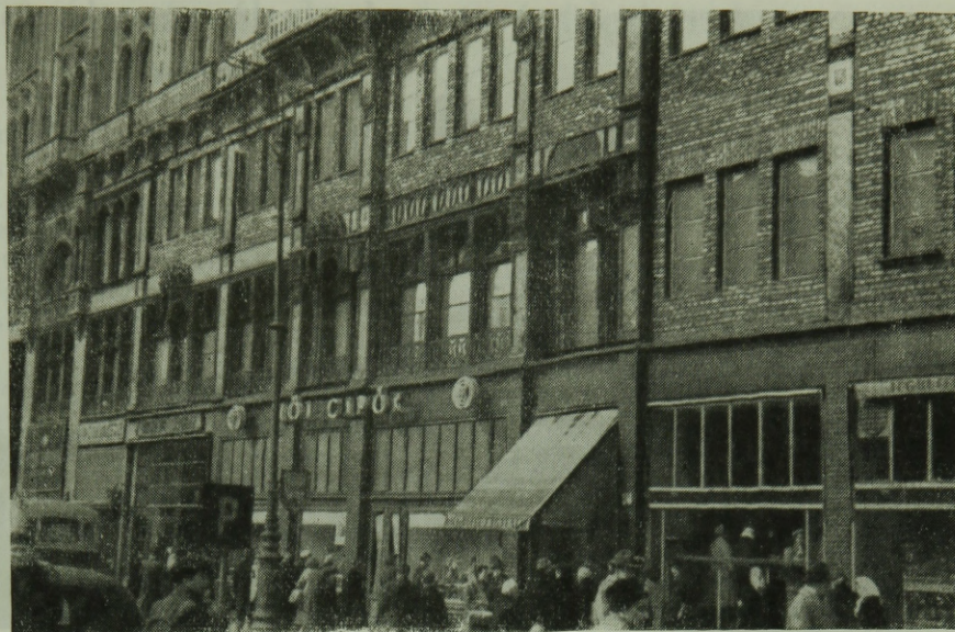
4. ábra. Felszabadulás tér 5. sz. Homlokzati fémdíszek és szerkezetek nagy terjedelemben hiányoznak
