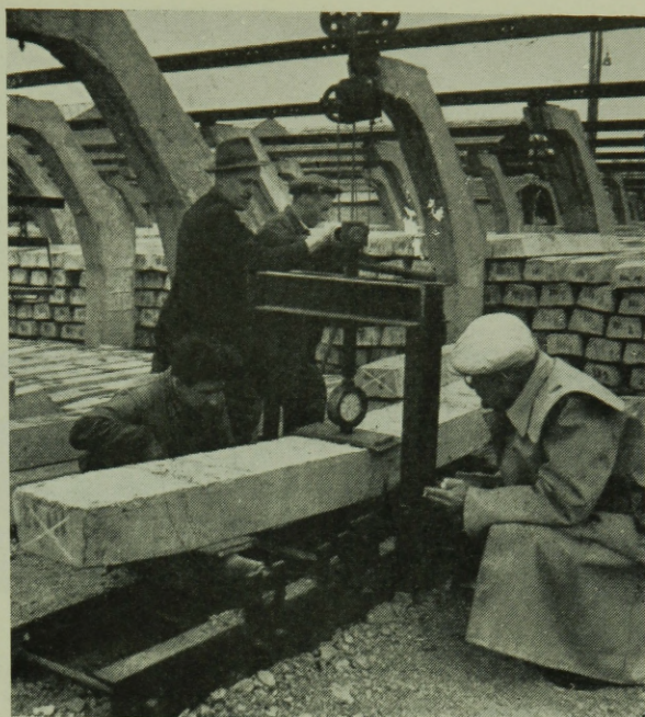
5. ábra. Vasbetonaljak próbatörése
