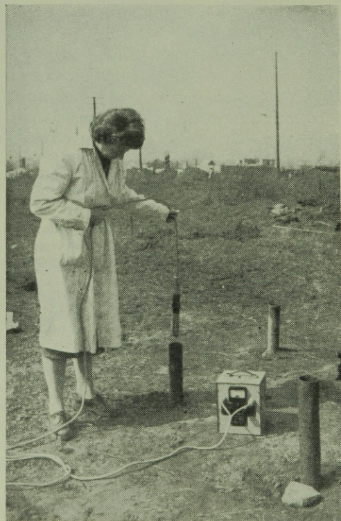
7. ábra. A kémlelő furatokban levő talajvíz sugáraktivitásának mérése szondával
