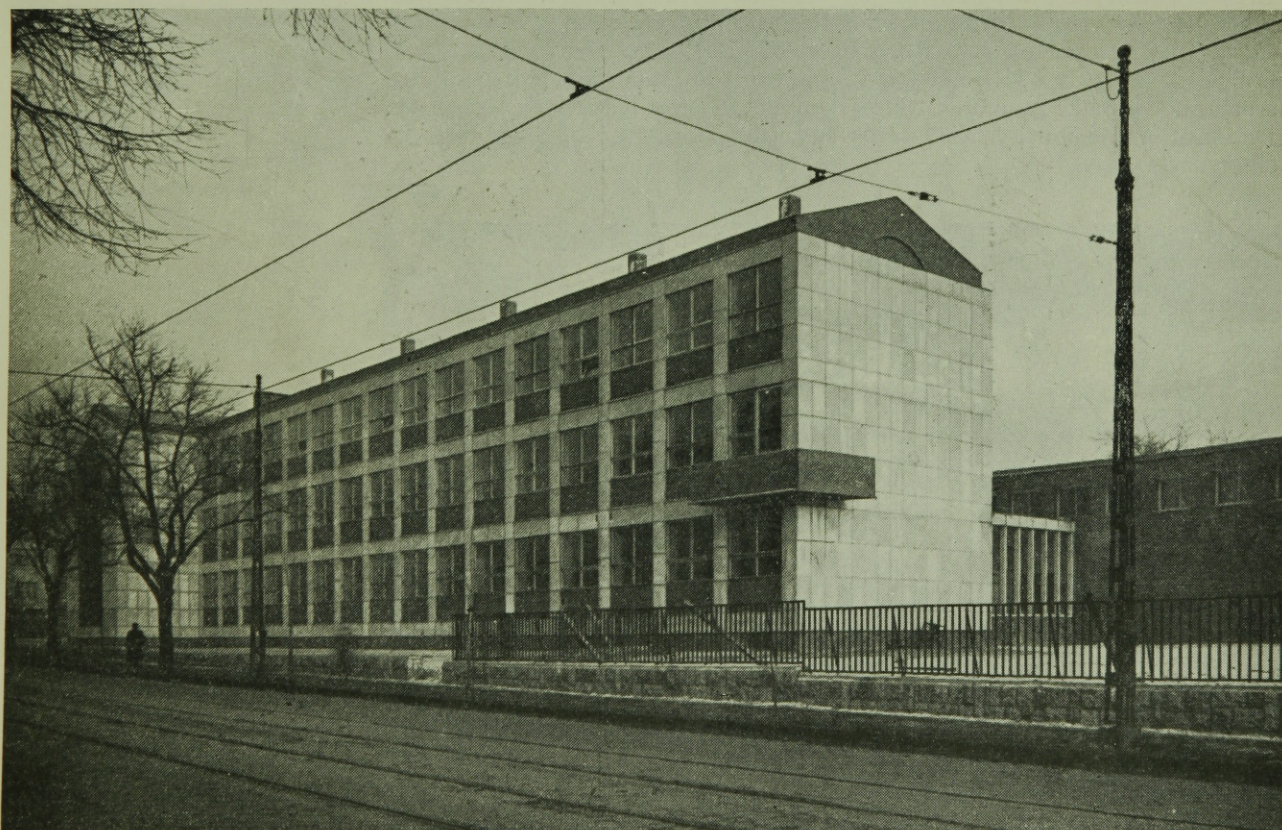
1. ábra. Homlokzat az Erzsébet királyné út felől
