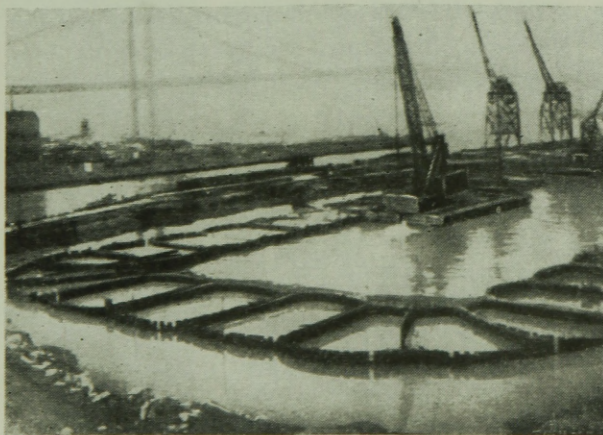
9. ábra. Philadelphiai szárazdokk építése. Sejtszáfalás körülzárás
