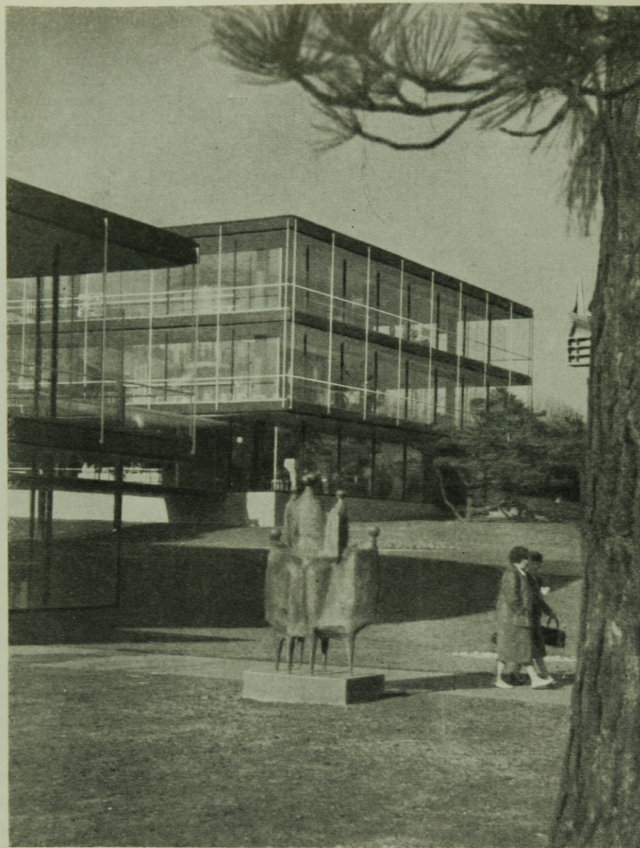
3. ábra. Német pavillon a Bruxel- les-i Világkiállításon. A homlok- zatok három oldalon befogott, egyenként 16 négyzetméteres „Securit” üvegtáblából készültek
