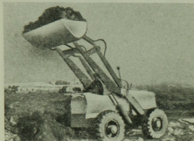
2. ábra. Gumikerekű homlokrakodó
