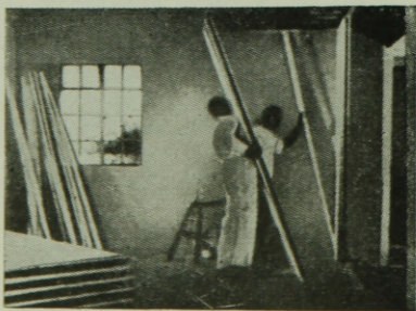
31. ábra. A rekeszes könnyű válaszfal elhelyezése
