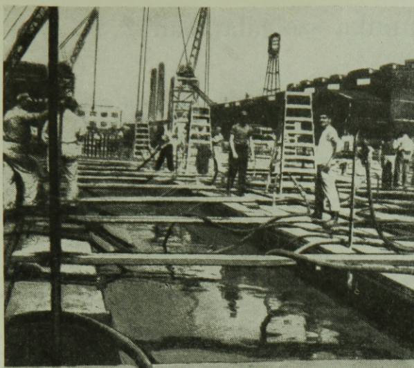
10. ábra. Philadelphiai szárazdokk építése prepakt habares vízalatti bepréselése
