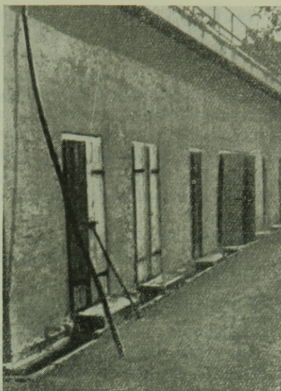
4. ábra. Száraz eljárású biogáz berendezés Pécs mellett (ürítő nyílások)
