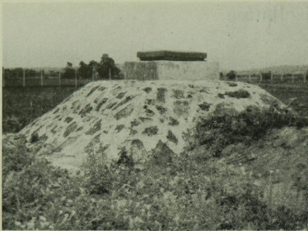
2. ábra. A vízmű 4. sz. kútja, a védőterületet övező kerítéssel
