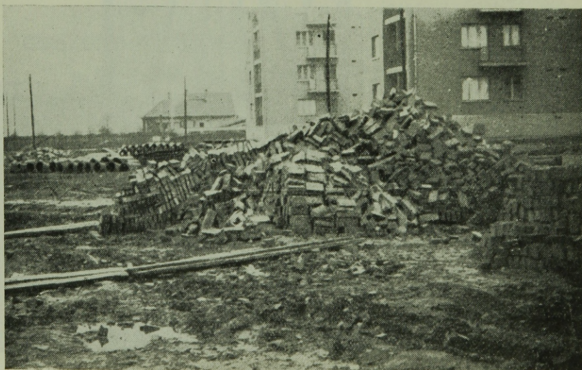
4. ábra. Helytelenül, el nem egyengetett területen, ömlesztve kiborított és tárolt téglák
