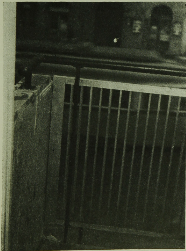
7. ábra. Vasszerkezettel gyámoltott alumínium erkélykorlát
