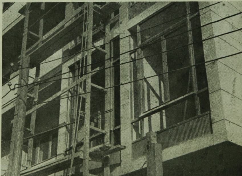
22. ábra. Középrészen kiülő alumínium ablak. Minden szárny nyitható
