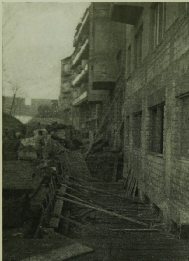
9. ábra. A „járdaakna“ kivitelezés közben
