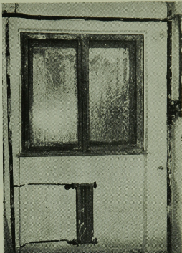
10. kép. Oh az az esztétika! Ha egy kicsit praktikusan a radiátor nem ül a konyhaablak közepén, mindjárt több hely lenne valami alacsony bútordarab elhelyezésére
