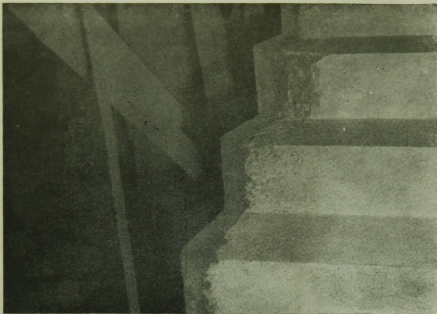
27. ábra. Alul is fogazott kialakítású lépcső- kar orsótér felőli utólagos kiképzése
