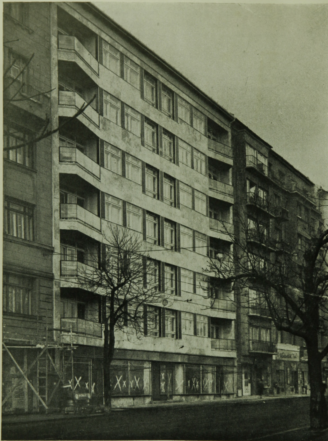
2. ábra. Krisztina krt. 83—85 sz. ház homlok- zata. Többféle burkoló- anyag alkalmazása, színes homlokzat
