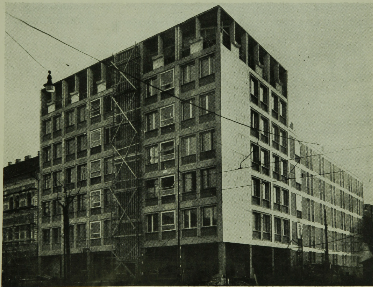
7. ábra. Üllői út 81. sz. ház homlokzata
