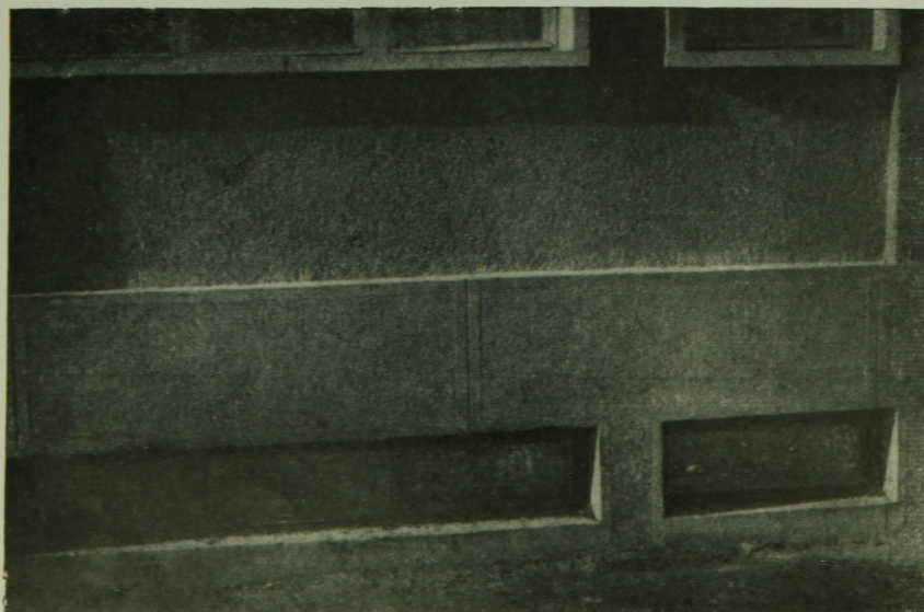
29. ábra. Szénledobó ablak. A szélesség — nem mondjuk, de a magasság?
