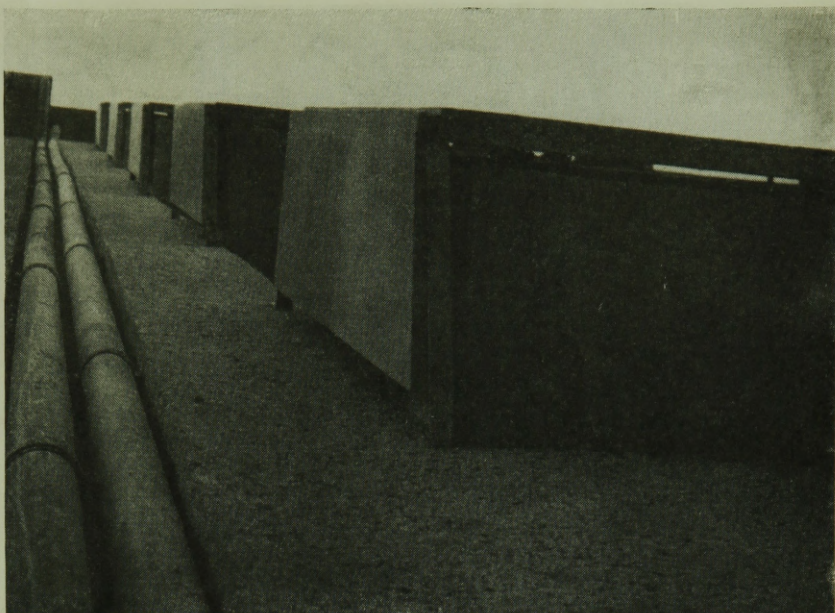
6. ábra. Kővel burkolt erkélyek alulról nézve. A csatlakozó lemezeket bizony egy kicsit elszabták
