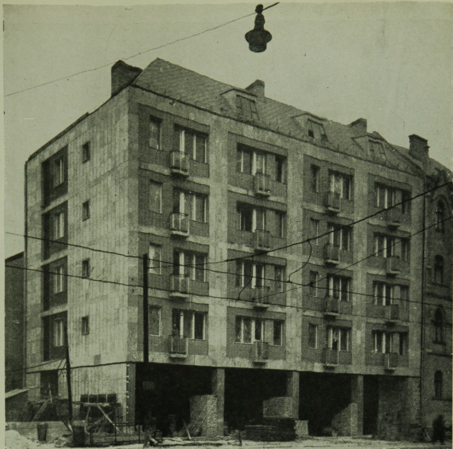
6. ábra. Üllői út 79. sz. ház homlokzata
