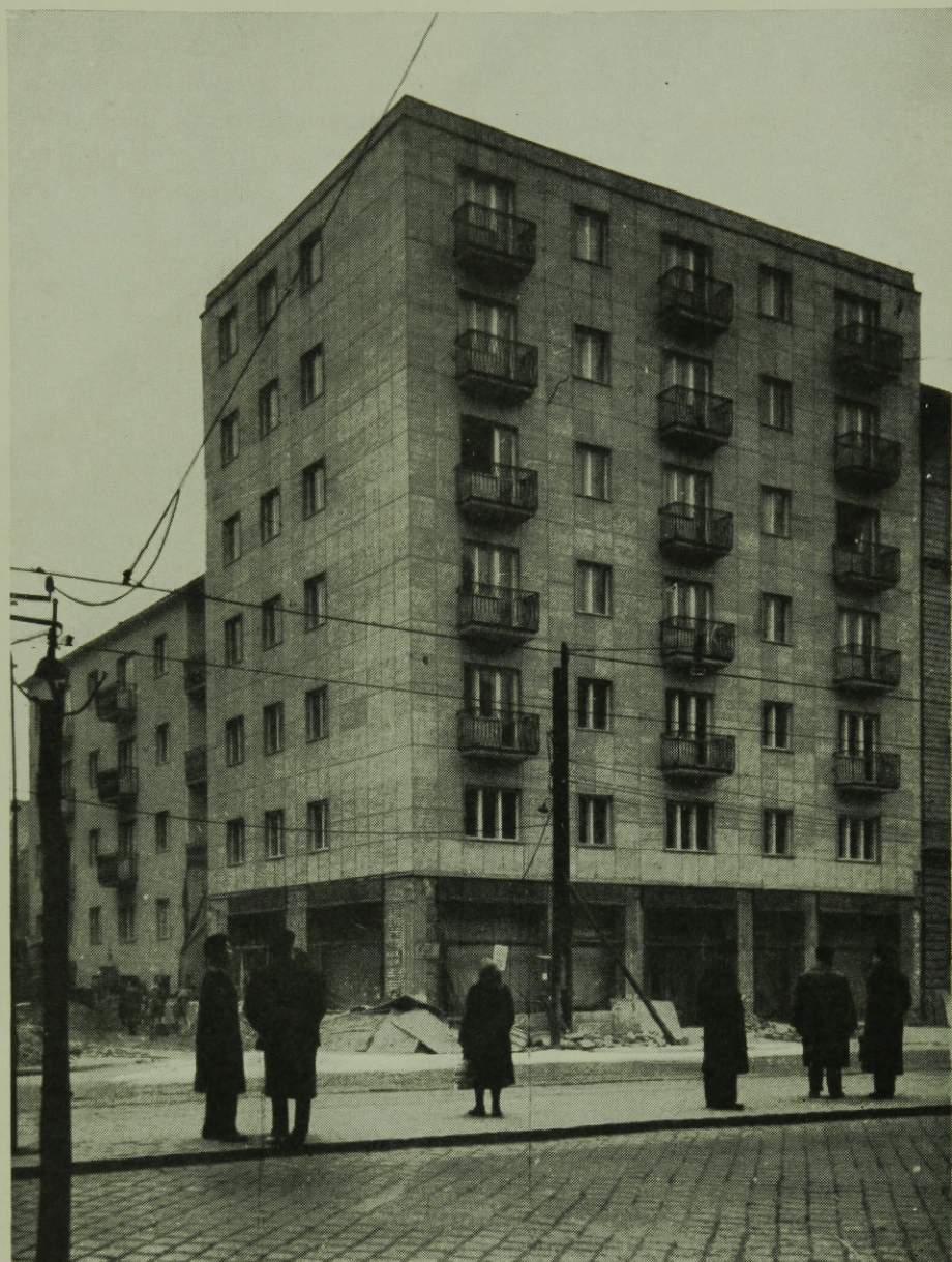
1. ábra. Üllői út 71. homlokzat
