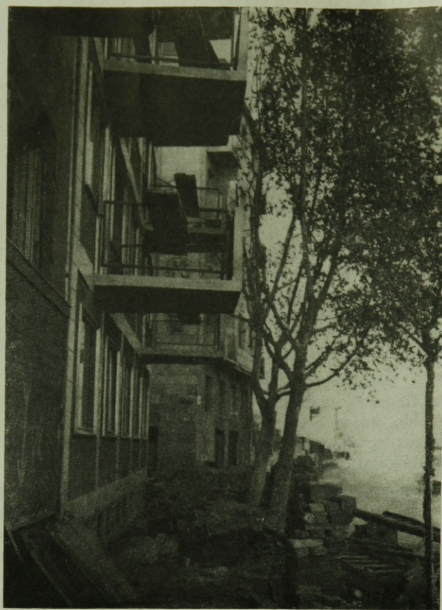
4. ábra. Merész kiülész erkélyek. A faablakok körül aluminium keretek
