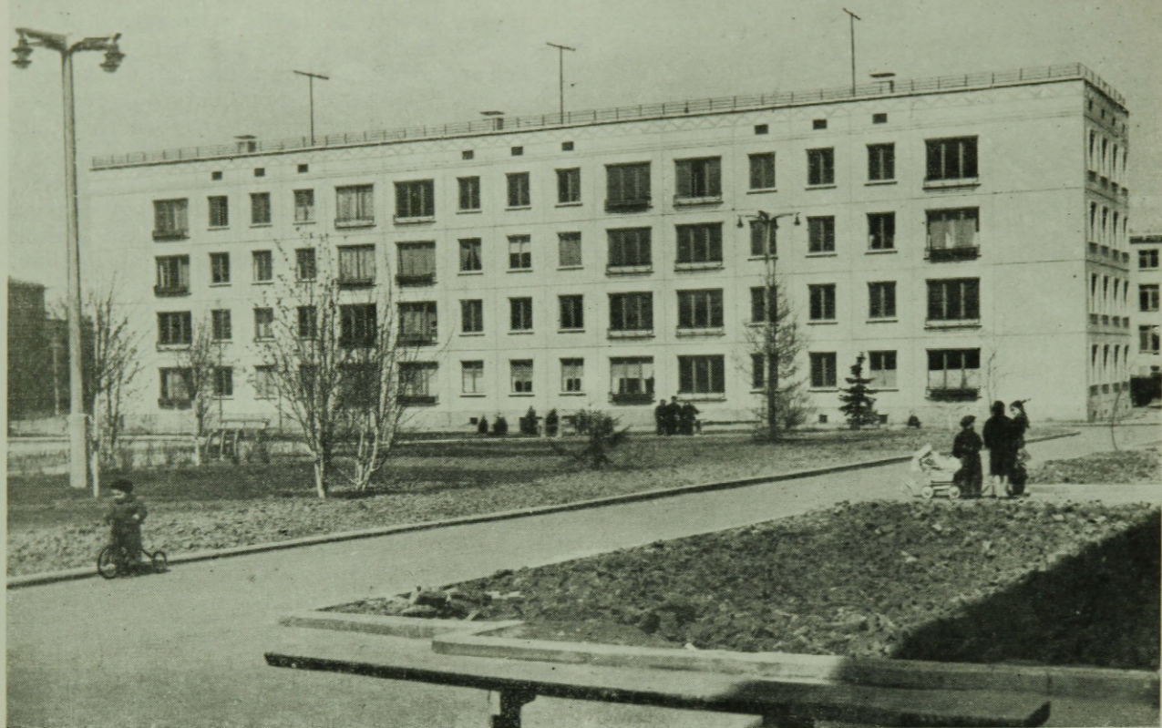
6. ábra. A kísérleti lakónegyed nagypanelekból készített 3 emeletes lakóépülete
